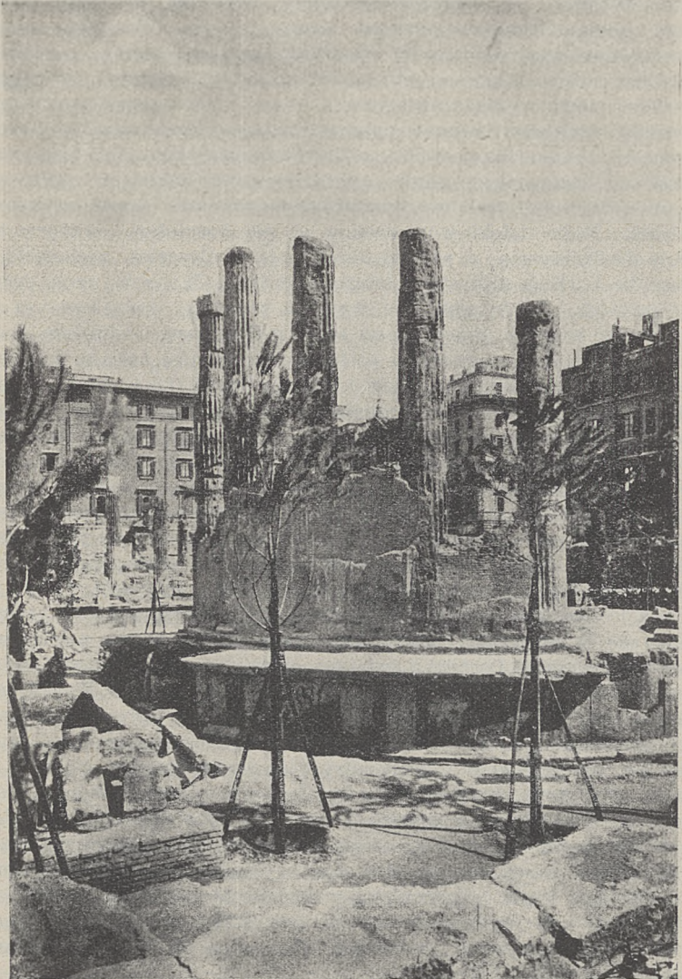
Podmurowanie i zachowane kolumny okrągłej świątyni B.
