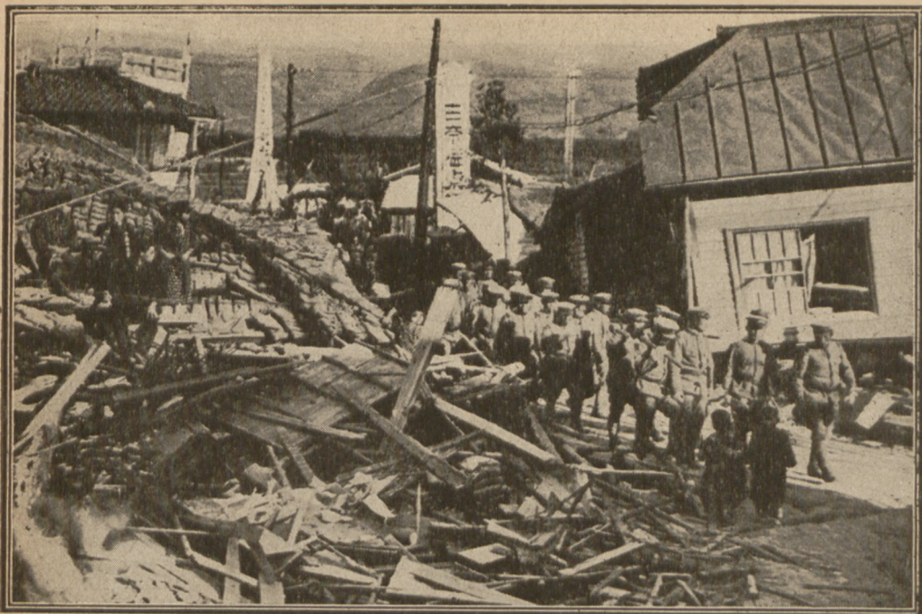
Straszne trzęsienie ziemi na japońskiej wyspie Formozie. Katastrofa, która nawiedziła wyspę na same święta wielkanocne 1935 r., pochłonęła zgrupą 3000 ofiar w ludziach. Przeszło 15.000 domów legło w gruzach, a przeszło 22.000 zostało uszkodzonych.
