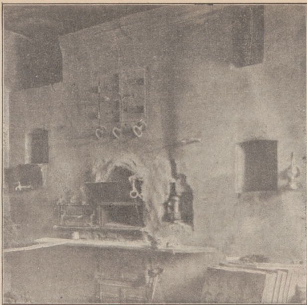
Część pieca piekarskiego, wypiekającego od razu 200 bochenków chleba w piekarni rolniczej w Łoniewej.
