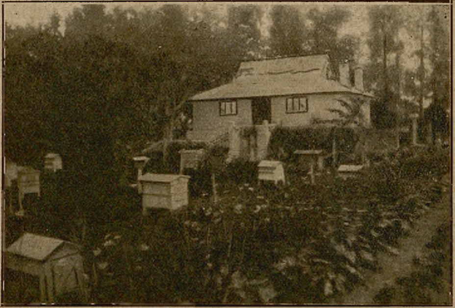
Stebnik magazyn na 60 uli w majątku Dzieleńtkowo p. Umińskiego. zbudowany w dolnej części z cegły palonej — górna część, zbudowana z pustaków, zawiera magazyn, pracownię, sialkownie na woszczyne.
