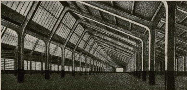
Ryc. 4. Nowoczesny dach spawany.
