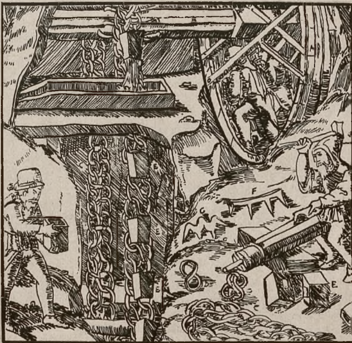
Ryc. 1. Wydobywanie z szybów górniczych w XVI. stuleciu za pomocą kublów, zawieszonych na łańcuchu, poruszanych przez koło dreptakowe (górną prawą stronę obrazu). Agricola „De re metallica“.
