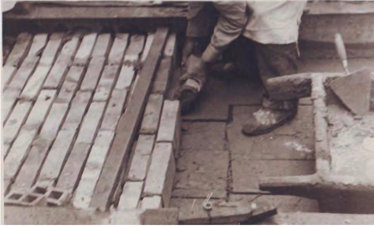
Fot. 2. Wykonywanie stropu Kleina (ok. 1928).
