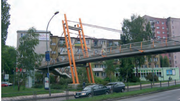
Rys. 5. Kładka w Kielcach (ul. Źródłowa). Fig. 5. A footbridge in Kielce.
