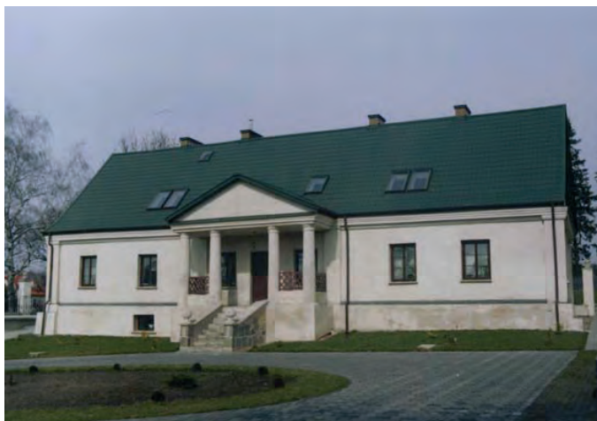
Fot. 3. Elewacja ogrodowa – 2008 rok.
