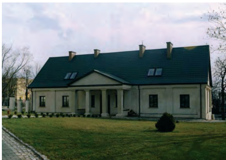
Fot. 2. Elewacja frontowa – 2008 rok.
