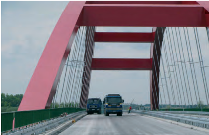
Rys. 19. Most w Puławach (stan 2). Fig. 19. A bridge in Puławy (phase 2).
