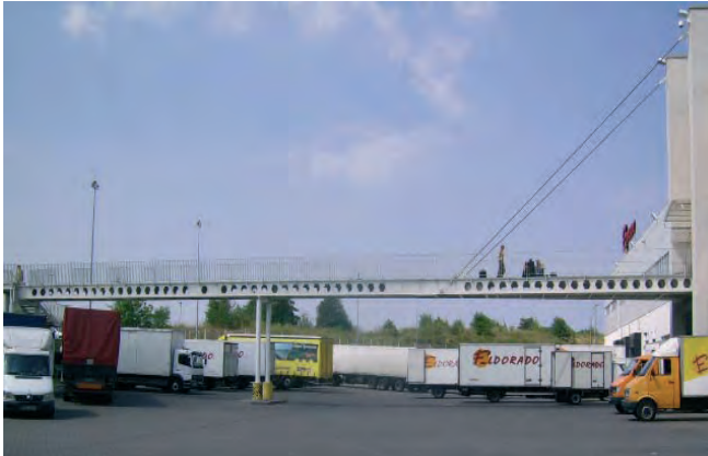
Rys. 8. Kładka przy hurtowni Eldorado w Lublinie. Fig. 8. A footbridge next to Eldorado warehouse in Lublin.
