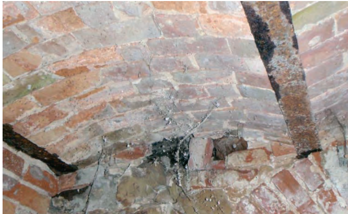
Fot. 1. Strop odcinkowy (ok. 1908r.).
