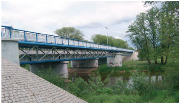
Rys. 6. Kładka nad rzeką Wartą w Osjakowie. Fig. 6. A footbridge over Warta River in Osjaków.
