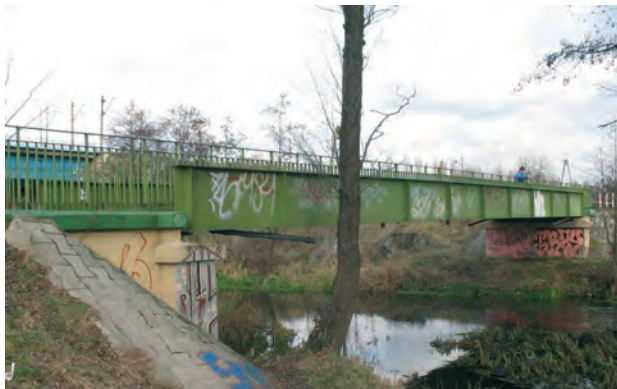
Rys. 7. Kładka nad rzeką Bystrzycą w Lublinie w sąsiedztwie ulicy Janowskiej. Fig. 7. A footbridge over Bystrzyca River in Lublin.
