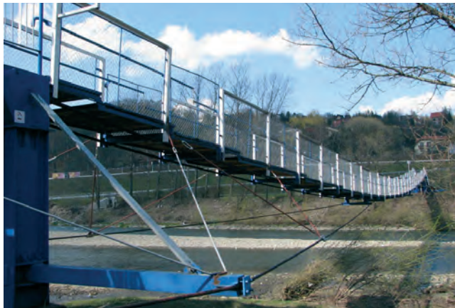
Rys. 9. Kładka wstęgowa w Myślenicach. Fig. 9. A stripped footbridge in Myślenice.
