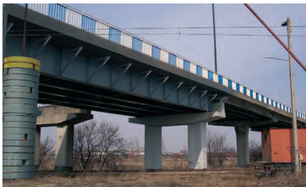
Rys. 14. Wiadukt na ulicy Grygowej w Lublinie.
