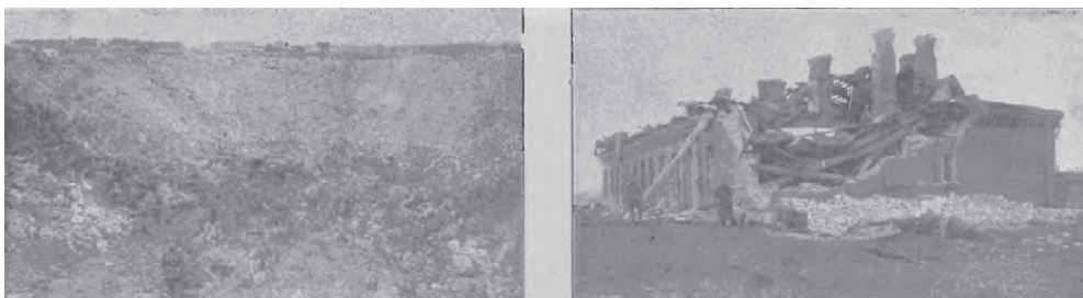
Ryc. 13. Lej po wybuchu oraz zniszczona kamienica – 1919 r. Fig. 13. Crater after explosion and destuctct tenement – 1919.
