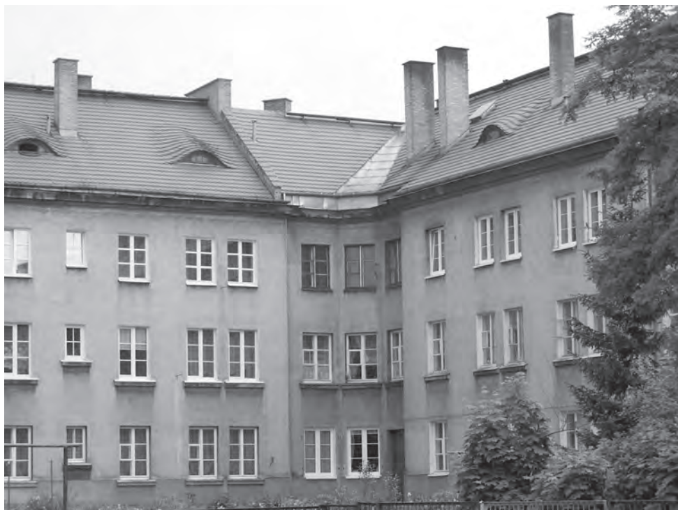
Rys. 15. Budynki typu IV i V Ulica Piłsudskiego.
