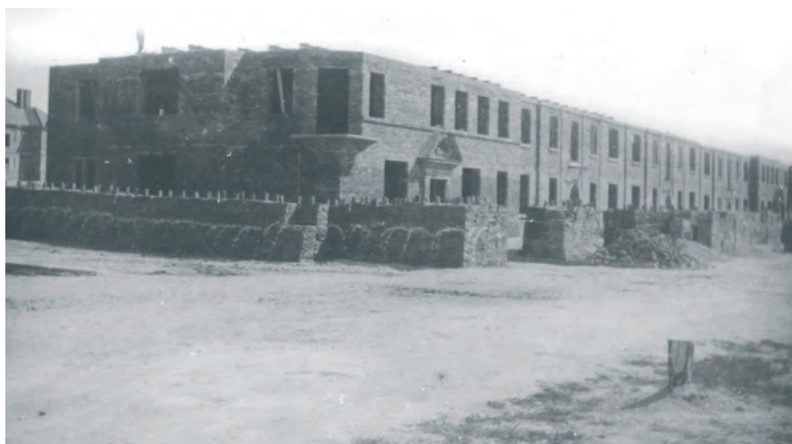
Rys 7. Budowa osiedla „Dyrekcja”, budynki mieszkalne [2].
