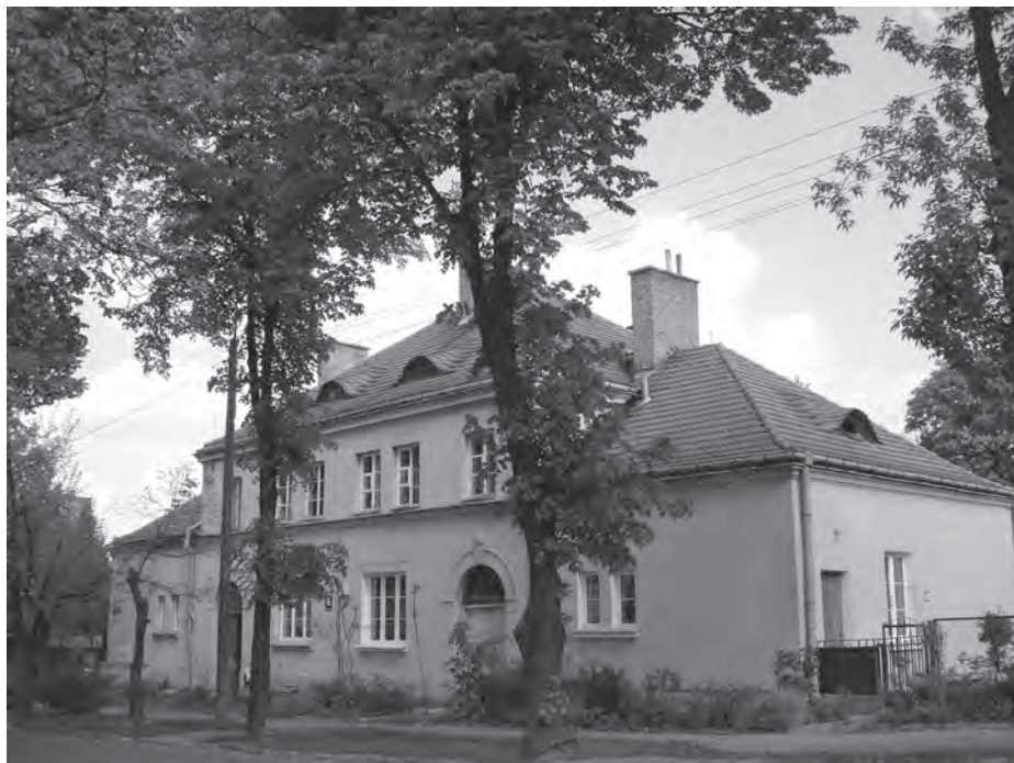
Rys. 12. Budynek typu II Ulica Czackiego.
