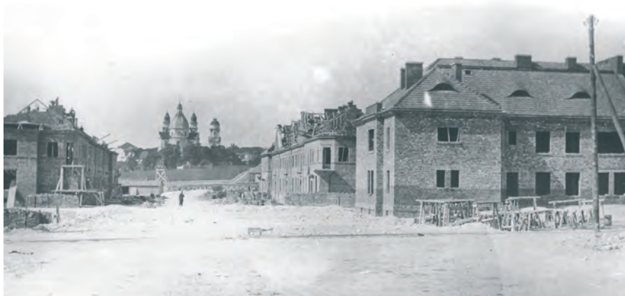
Rys 6. Budowa osiedla „Dyrekcja”, w głębi widok wzgórza katedralnego [2].
