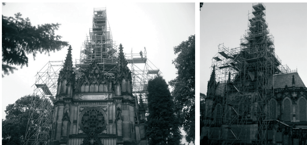
Rys. 8. Rusztowanie usytuowane wokół Kaplica Karola Scheiblera w Łodzi. Fig. 8. Scaffolding standing by Karol Scheibler Chapel in Łódź.
