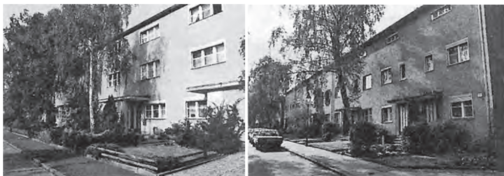
Rys. 19, 20. Domy szeregowe w osiedlu Onkel-Toms-Hütte zaprojektowane w oparciu o te same układy rzutów stworzone przez Brunona Tauta i fasadach ukształtowanych w różny sposób. Rys. 19. Zabudowa o formie architektonicznej ukształtowanej przez Otto Rudolfa Salvisberga. Rys. 20. Zabudowa o formie ukształtowanej przez Hugo Häringa z charakterystycznym zgrupowaniem wejść do segmentów w pary. Źródło: Wörner i inni [2].
