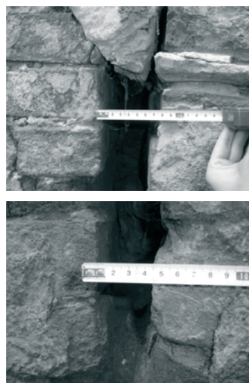
Rys. 10. Przykładowy rysunek inwentaryzacyjny zarysowań i pomiar rozwartości rysy.
