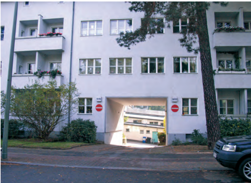
Rys. 5. Brama umożliwiająca pojazdom zaopatrzenia północnego pasażu handlowego wyjazd z kwartału. Zdjęcie: Hubert Trammer – 21 X 2006.
