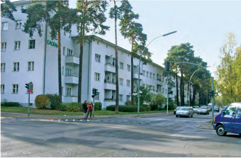
Rys. 4 Zabudowa mieszkaniowa wypełniająca północno-wschodni narożnik kwartału w którym znajduje się stacja metra wraz z towarzyszącym jej zespołem handlowo-usługowym. Widoczny charakterystyczny dla zamkniętych kwartałów na terenie osiedla wklęsły narożnik. Zdjęcie: Hubert Trammer – 21 X 2006.
