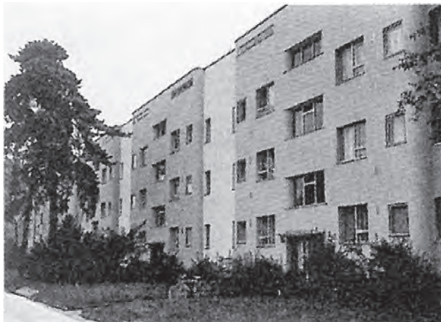
Rys. 14. Peitschenknall – najdłuższy budynek w osiedlu Onkel-Toms-Hütte – fragment elewacji od strony Argentinische Alle. Widoczne zaokrąglenia krawędzi ryzalitów i okien klatki schodowej. Źródło: Wörner i inni [2].
