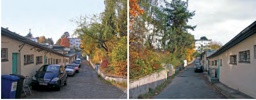
Rys. 9, 10. Zaplecza pasaży handlowych towarzyszących stacji metra Onkel-Toms-Hütte. Widoczne tylne elewacje pasaży handlowych. Powyżej murów oporowych położone na poziomym terenie przestrzenie zielone przy budynkach mieszkalnych zamykających kwartał od strony północnej i południowej. Zdjęcia: Hubert Trammer – 21 X 2006.
