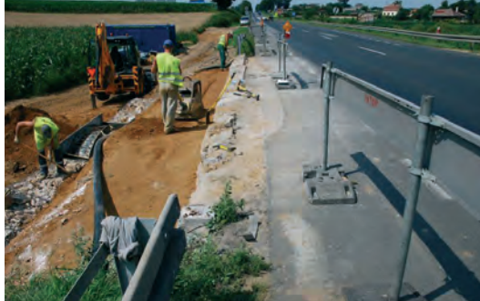
Fot. 5. Zagęszczanie zasyпки [10]. Phot. 5. Compaction of backfill [10].
