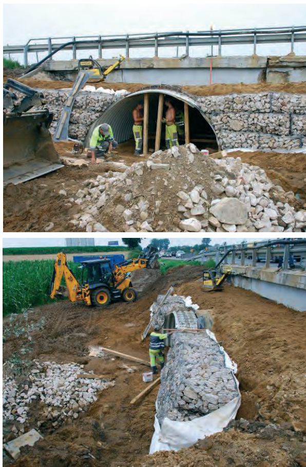
Fot. 4. Montaż konstrukcji stalowej z blachy falistej wraz z ustawieniem gabionów [10]. Phot. 4. Assembly of corrugated steel with setting gabions [10].
