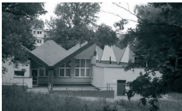
Rys. 6. Budynek przedszkola, 2009, fot. Zyclunt, forum skyscrapercity.com Fig. 6. Kindergarten.
