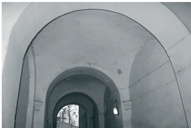
Fot. 2. Sklepienia przejazdu
