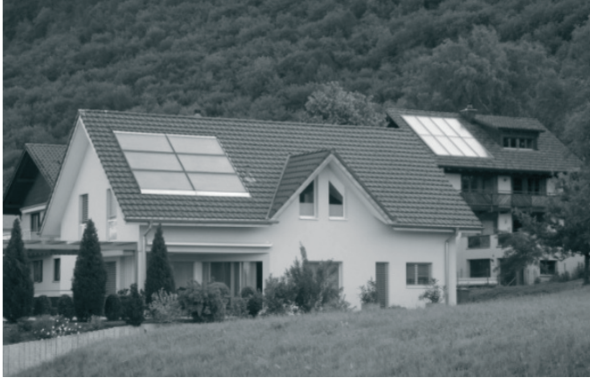
Rys. 1. Porównanie architektury budynków mieszkalnych w Lichtensteinie: a) domy jednorodzinne z lat 70-tych, b) architektura mieszkaniowa z lat 30-tych, c,d) realizacje ukończone w latach 2010 - 2011, fot. N. Przesmycka, 2011.
