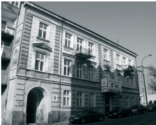
Fot. 1. Elewacja frontowa.
