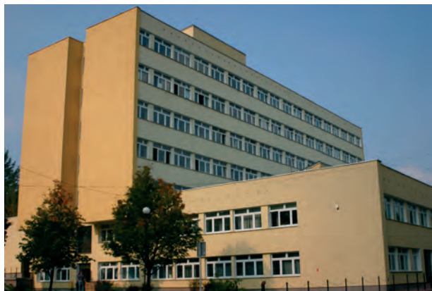
Fot. 1. Budynek Wydziału Budownictwa i Architektury Politechniki Lubelskiej. Fot. J. Wrana, 2009.
