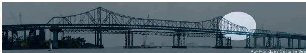
Rys. 1 Widok mostu Bay Bridge w San Francisco z zaznaczeniem rejonu uszkodzenia [2]
