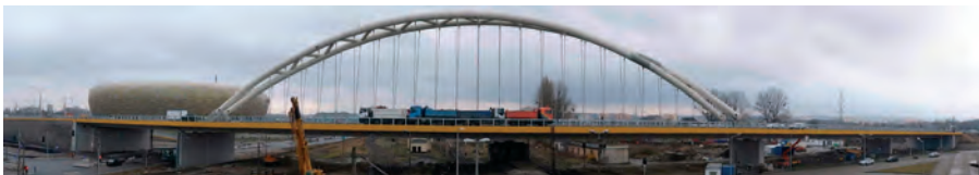
Rys. 7. Ustawienie U2 obciążenia próbnego
