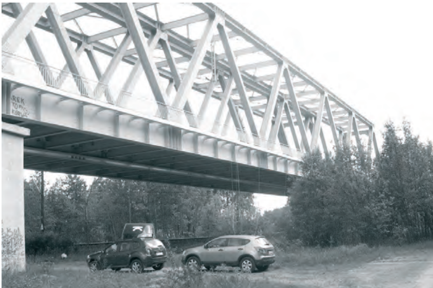
Rys. 1. Widok wiaduktu w czasie badań.
