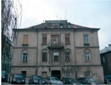
Rys. 3. Kamienica Pawęczkowskiego. Elewacja frontowa. Autor zdj. A. Jarocka-Mikrut
