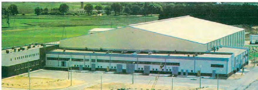
Rys. 1. Chłodnia w konstrukcji stalowej z lekką obudową [3]
