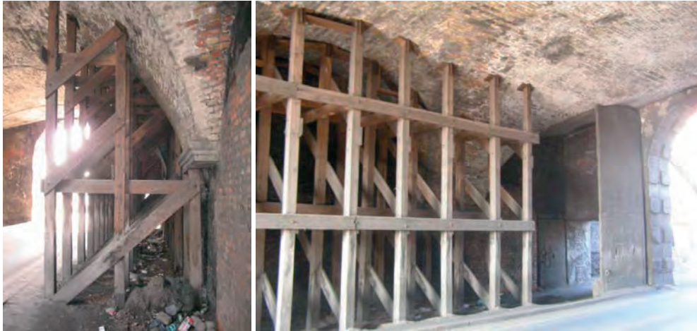
Rys. 3. Przejazd Bramy Nizinej z widoczną drewnianą kratownicą
