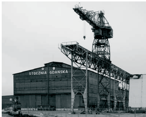
Rys. 2. Estakada B-5 oraz dźwignica od strony ul. Jana z Kolna (fot. Ł. Pyrzowski)
