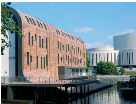
Rys. 1. Przykład elewacji drewnianej. Autor: Wiktor Blaszkiewicz
