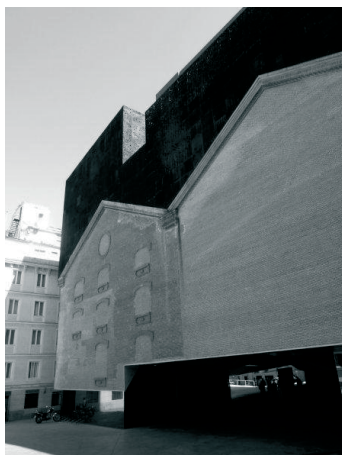
Fot. 3. Madryt – historyczne elewacje wykorzystane w nowoczesnym budynku wystawienniczym, (fot. B. Szmygin).
