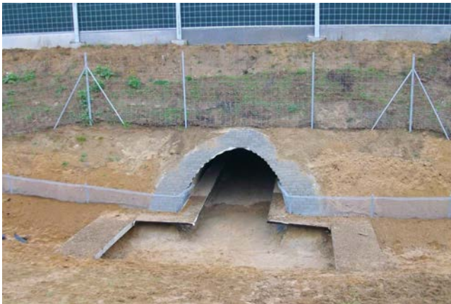
Rys. 1. Przykład obiektu w Zadaniu 1 – most nad rzeką Kurówką z przejściem dla dużych zwierząt (fot. M.Kowal).
