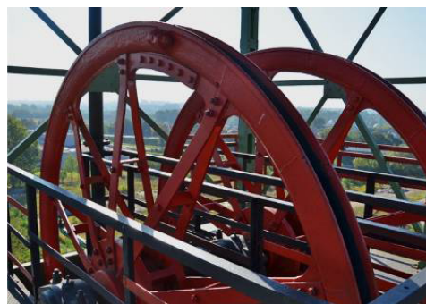
Rys. 3. Szyb Maciej - widok z platformy widokowej 4 .
