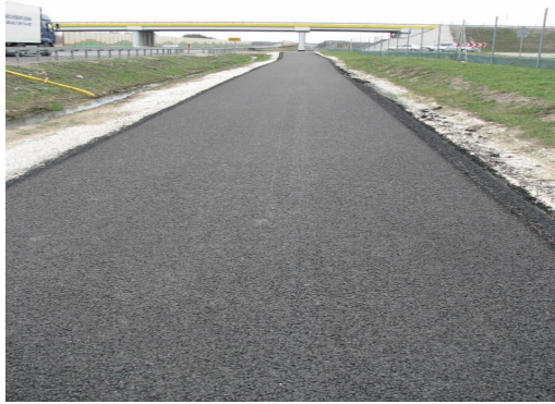
Rys. 3. Odcinek doświadczalny cichych nawierzchni
