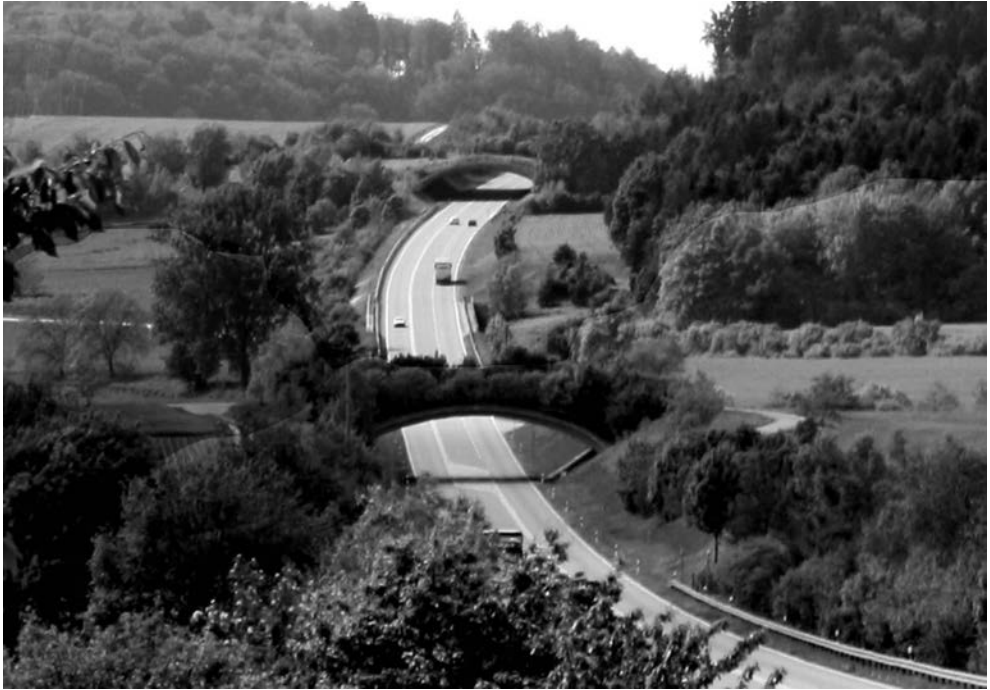
Fot. 2. Przejścia nad drogą B31neu w Niemczech wybudowane latach 1992-93 (łącznie 5 obiektów) określiły europejskie standardy projektowania przejść (Fot. R. Kurek).
