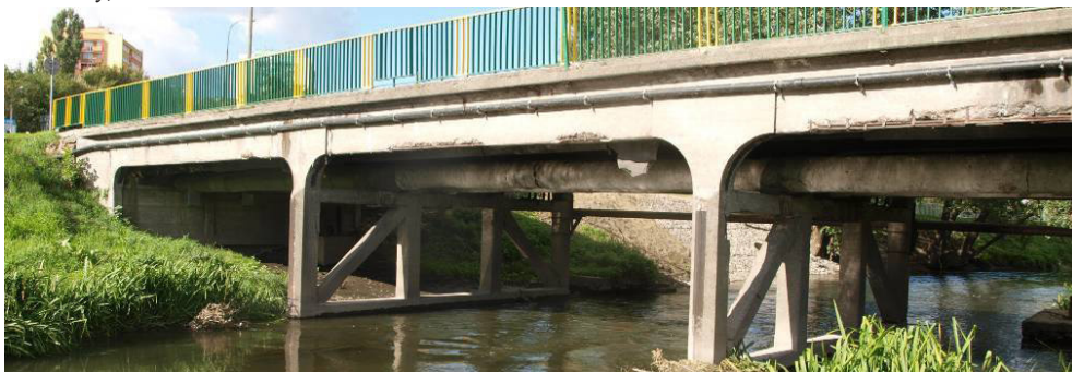
Rys. 6. Widok mostu na Kalinowszczyźnie od napływu; stan - 2013 r.
