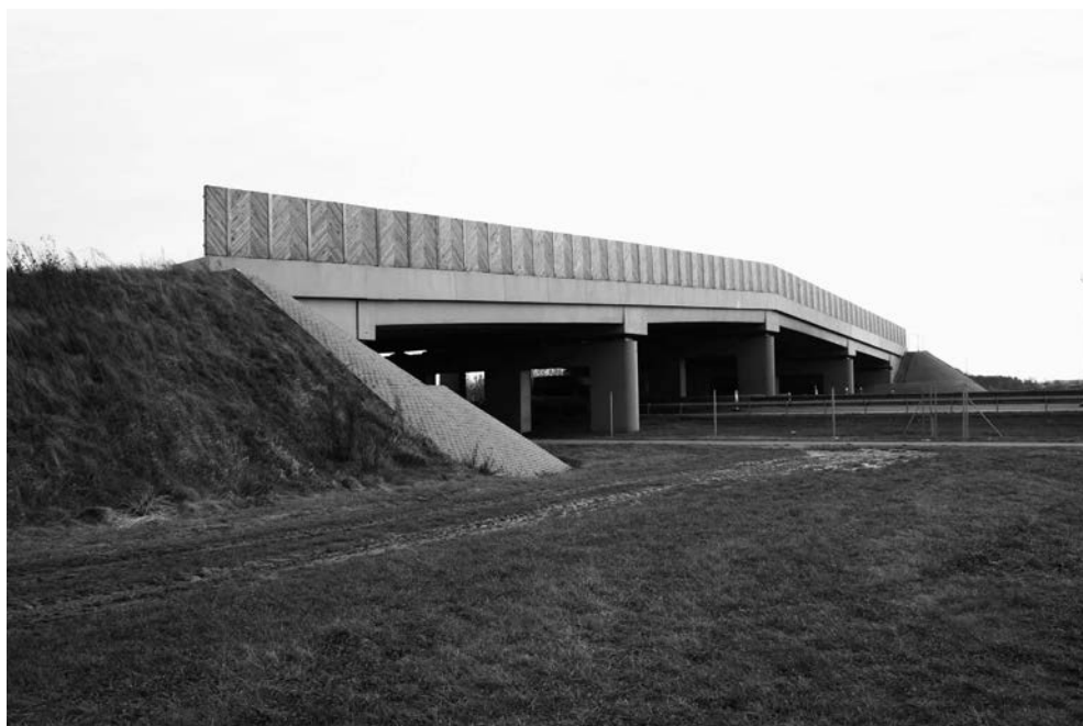
Fot. 5. Początki budowy przejść górnych przy autostradzie A2 nie były zbyt udane m.in. przez brak ich właściwego wkomponowania w otoczenie – betonowy obiekt na odcinku: Września-Konin (Fot. R. Kurek).
