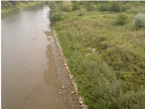
Rys. 3. Umocnienia rzeki nawiązujące do jej charakteru – stan w roku zakończenia robót (fot. A. Dąbal).
