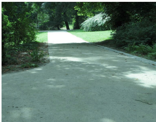
Rys. 7. Nawierzchnia wodoprzepuszczalna z kruszyw niezwiązanych stabilizowana środkiem pochodzenia roślinnego.
