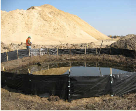
Fot. 7. Wygradzenia na placu budowy.
