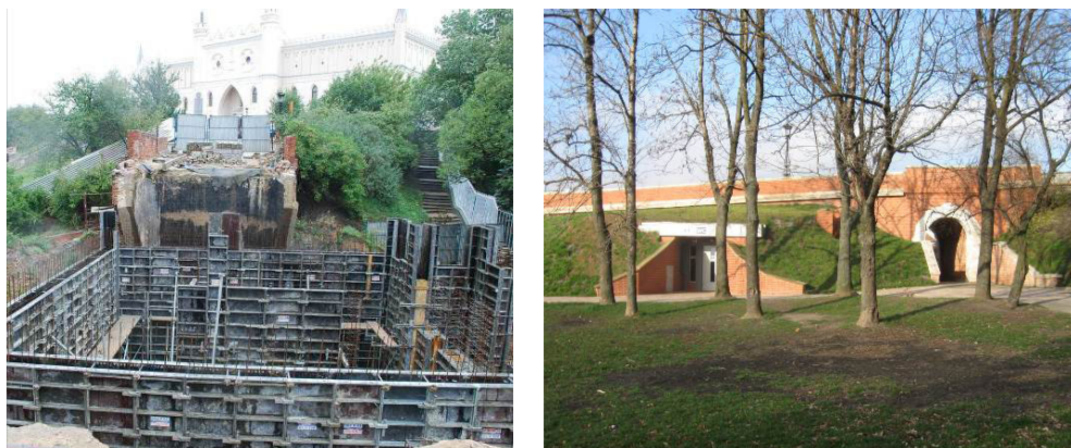
Fot. 19. Budowa szaletu miejskiego [4 i 5].
