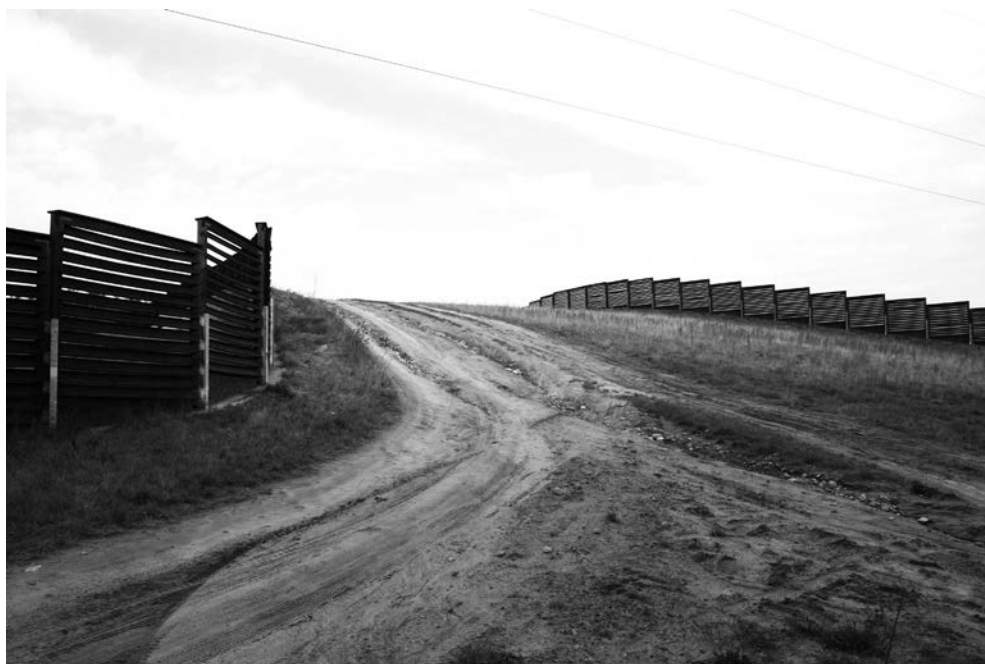
Fot. 10 Ubogie zagospodarowanie powierzchni i brak zabezpieczeń przed przejazdami, to wciąż ważne problemy przejść nad drogami, znacząco ograniczające ich skuteczność (Fot. R. Kurek)
