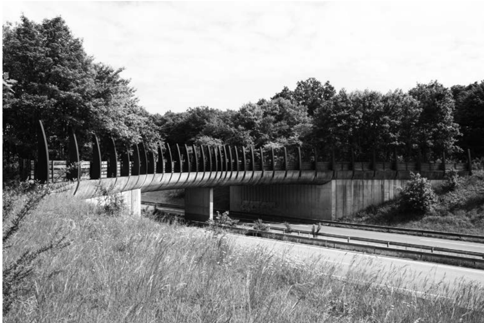
Fot. 1. Przejście górne wybudowane ok. 30 lat temu we Francji (autostrada A36) – pomimo małej szerokości (15 m), zwraca uwagę optymalne wkomponowanie w otoczenie i zabudowa biologiczna (Fot. R. Kurek).
