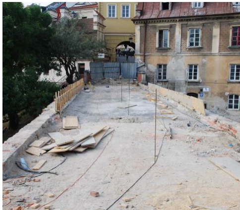
Fot. 17. Całkowite rozebranie nawierzchni i stan po przebudowie [4 i 5].
