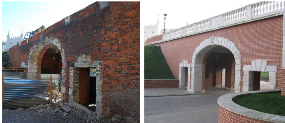
Fot. 18. Widok wiaduktu w trakcie remontu i po jego ukończeniu [4 i 5].
