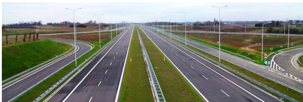
Rys. 7. Widok na trasę S17 z węzła „Lublin Sławin” w kierunku Warszawy (fot. M.Kowal).
