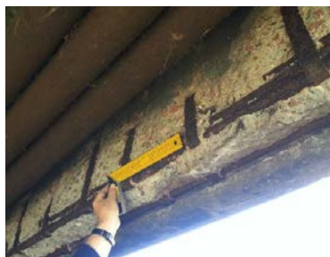
Rys. 16-17. Korozja żelbetu belek i płyty pomostu.
