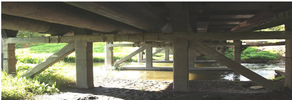
Rys. 13. Filary mostu na Kalinowszczyźnie.
