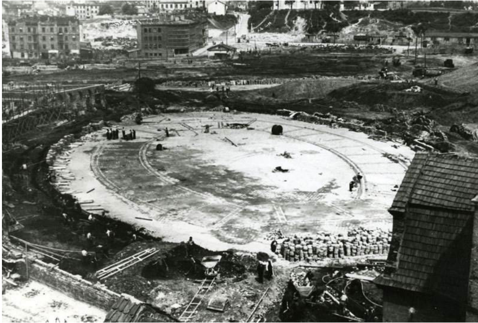
Fot. 2. Budowa placu Zamkowego [6].
