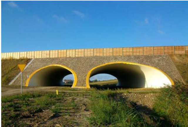
Rys. 5. Przejazd gospodarczy i most nad ciekim z przejściem dla średnich zwierząt (Zadanie 1) (fot. M.Kowal).
