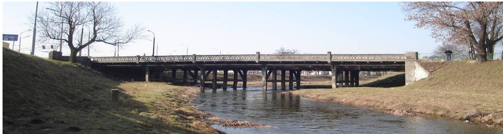
Rys. 19. Widok drugiego mostu M. Lutosławskiego, stan z 2006 r.
