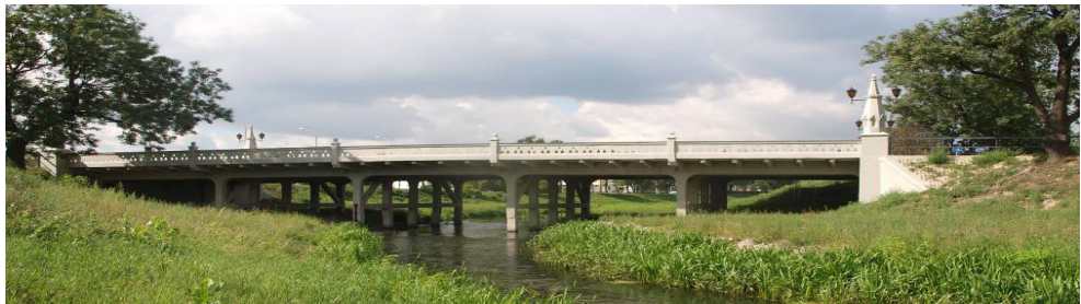
Rys. 20. Most w ciągu ulicy Zamojskiej – stan obecny.
