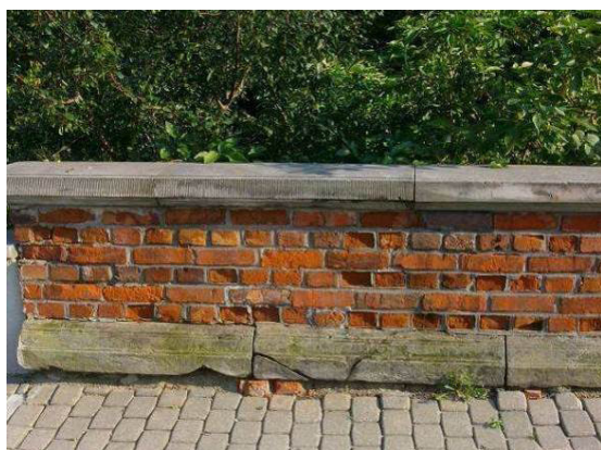
Fot. 13. Murek na skrzydle: zniszczone elementy podstaw, ubytki cegieł oraz osuwanie się zasyпки pod skrzydłem [4].
