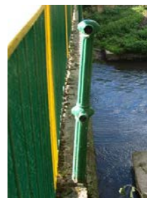
Rys. 18. Pozostałości żeliwnych słupków.
