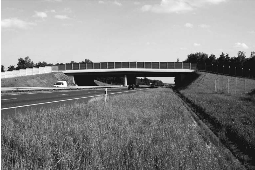
Fot. 6. Pierwsze w pełni funkcjonalne przejście górne przy drodze zarządzanej przez GDDKiA – autostrada A4, odcinek: Kleszczów-Sośnica (Fot. R. Kurek).
