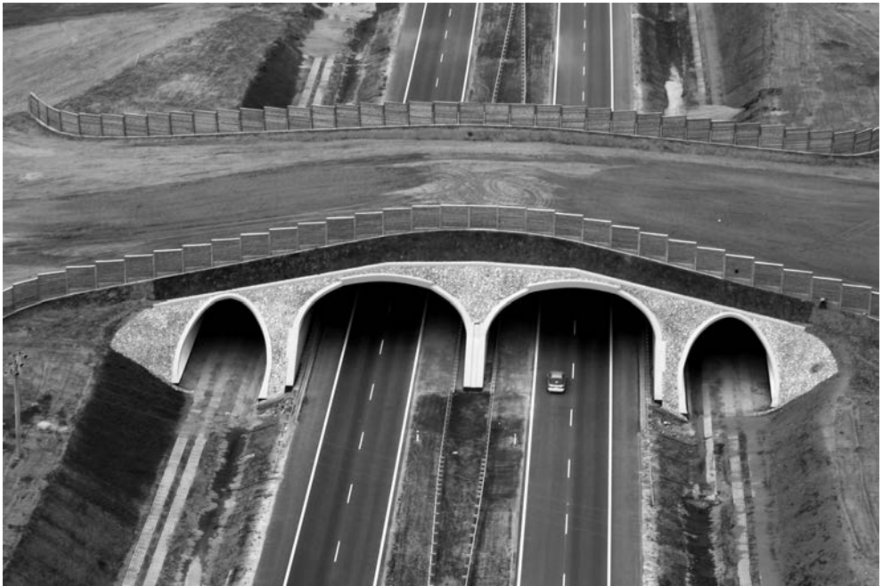
Fot. 7. Jedno z dwóch przejść, od których zaczęła się w Polsce epoka budowy dobrze zaprojektowanych „zielonych mostów” – autostrada A2 (odcinek: Konin-Koło) (Fot. Viacon Polska).
