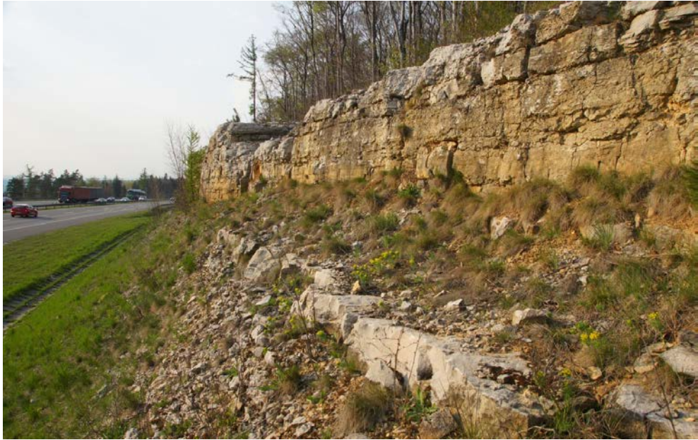
Fot. 3. Pozostawione w pasie autostrady wychodnie skał wapiennych. (Fot. Krzysztof Spałek)
