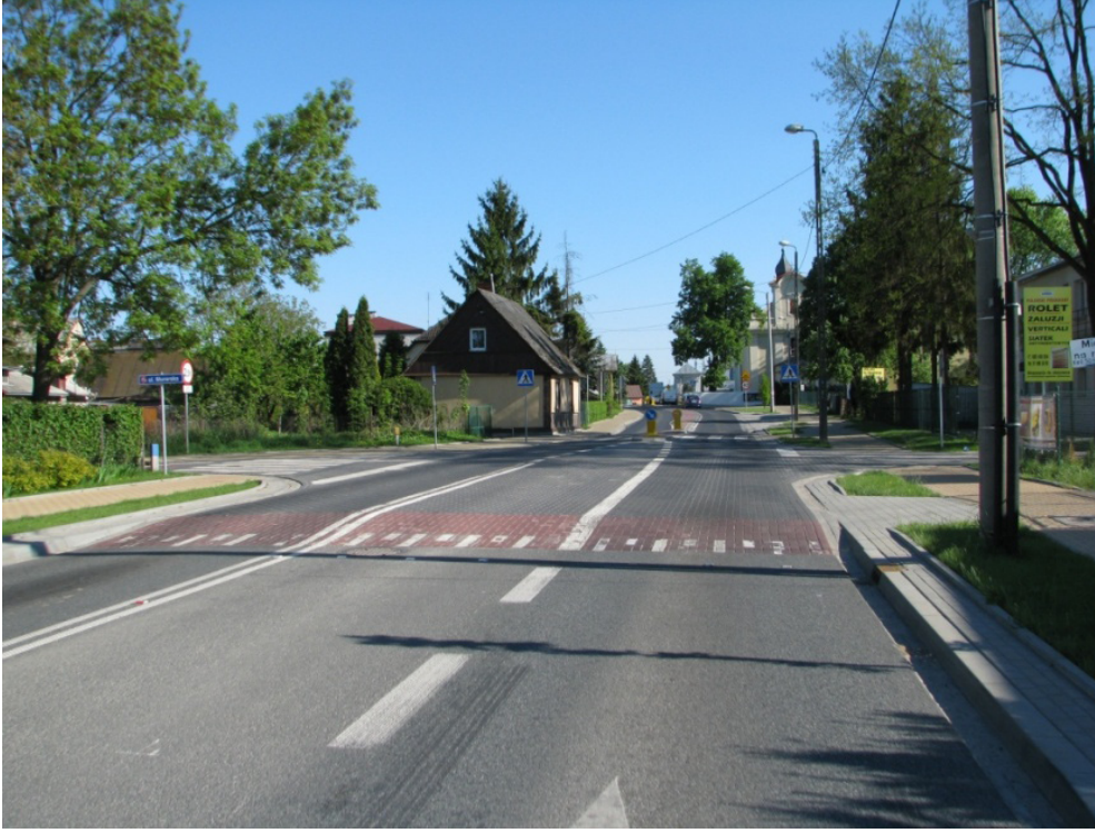
Fot. 2. Wyniesiona powierzchnia skrzyżowania na drodze wojewódzkiej nr 824 w Puławach
