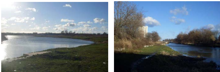
Rys. 11-12. Rzeka Styr. W tle most w ciągu ul. Szewczenki.
