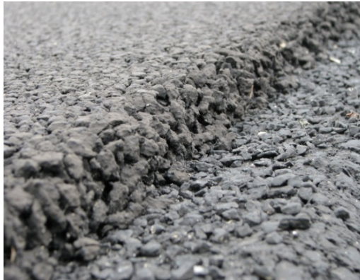
Rys. 4. Nawierzchnia wykonana w technologii asfaltu porowatego
