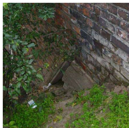
Fot. 13. Murek na skrzydle: zniszczone elementy podstaw, ubytki cegieł oraz osuwanie się zasyпки pod skrzydłem [4].
