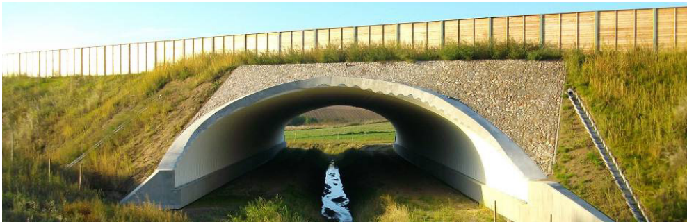
Rys. 8. Przejście dla średnich zwierząt na odcinku „Kurów Zachód” – „Jastków” (fot. M.Kowal).
