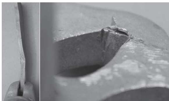
Rys.10. Forma zniszczenia węzła w przypadku zginania rygla z płaszczyźnie poziomej
