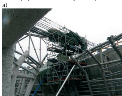
Rys. 1. Rusztowanie modułowe, wykorzystywane do malowania konstrukcji stalowej w Muzeum Historii Żydów Polskich w Warszawie: a) widok rusztowania, b) schemat statyczny konstrukcji
