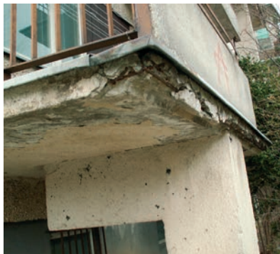
Rys. 1, 2. Przykłady degradacji elementów cienkościennych
