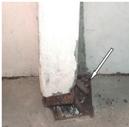
Rys. 8. Widok podstawy słupa po utracie stateczności
