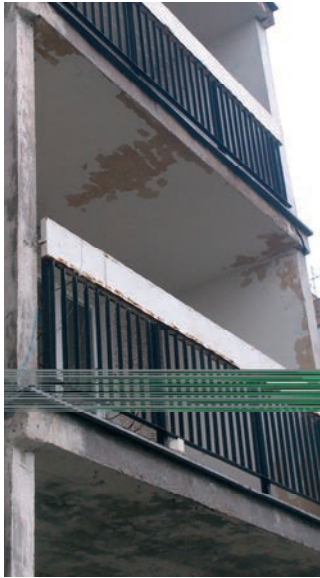
Rys. 1. Degradacja balkonów
