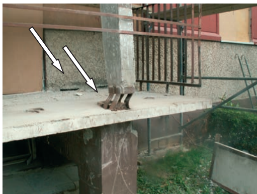
Rys. 10. Słup jw. przygotowany do naprawy – prostowania
