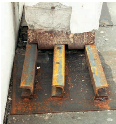
Rys. 9. Tymczasowe podparcie słupa
