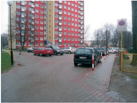
Fot. 5. Dawny plac zabaw przekształcony na plac parkingowy
