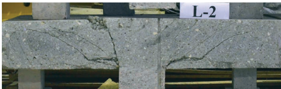
Rys. 6. Przekrój modelu L-2 z widocznymi rysami omijającymi zbrojenie poprzeczne
