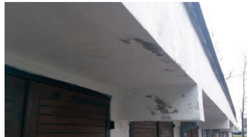
Rys. 4. Garaż – zawilgocenie
