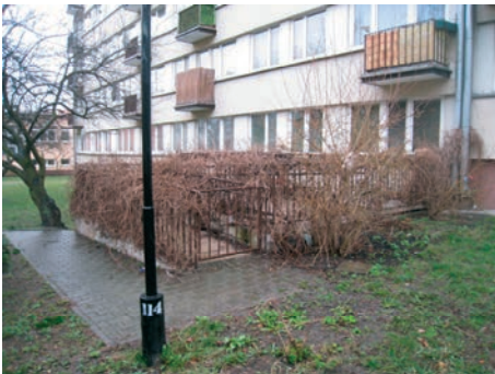
Fot. 9. Pochylnia dla niepełnosprawnych doprowadzona bezpośrednio do mieszkania.
