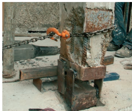
Rys. 11. Widok słupa po zakończeniu operacji prostowania i stabilizacji
