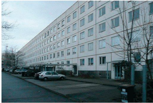
Rys. 4. Budynek przed przebudową [7]
