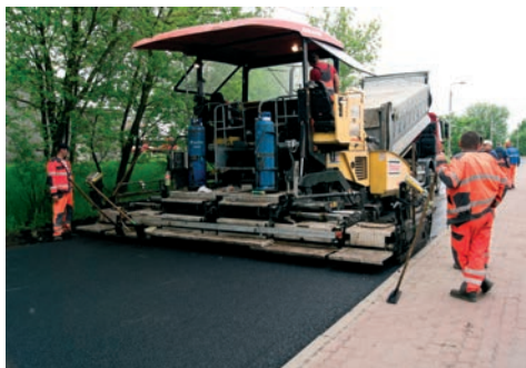
Fot. 2. Wbudowywanie i zagęszczenie warstwy
