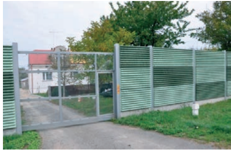
Rys. 1. Badany ekran akustyczny: a) widok od strony drogi, b) brama wjazdowa i chroniony budynek
