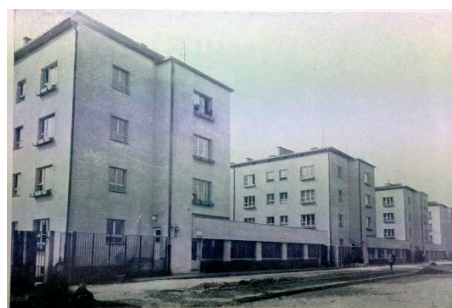
Rys. 8. Parterowe pawilony usługowe między budynkami przy ul. Stanisławowskiej [15] Fig. 8. Ground-floor service pavilions between buildings in Stanislawowska Street
