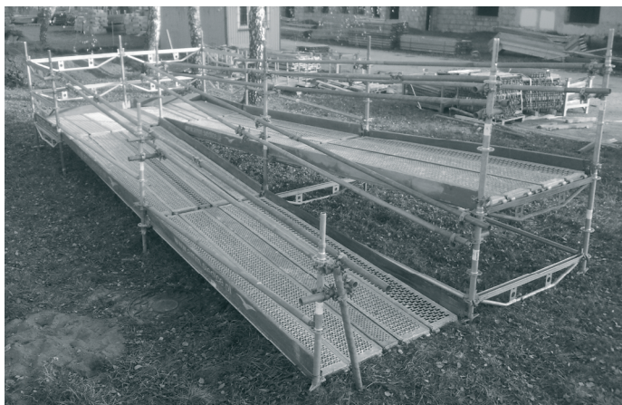
Rys. 2. Pochylnia dla osób niepełnosprawnych wykonana z elementów modułowego rusztowania ROTAX
