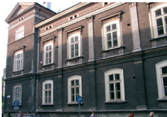
Rys. 5. Specjalny Ośrodek Szkolno-Wychowawczy nr 1 w Krakowie – budynek szkoły przy ul. Szujskiego
