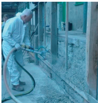
Rys. 5. Mechaniczny natrysk mieszanki wapienno-konopnej [archiwum autorów]
