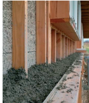
Rys. 4. Technika wykonania ściany z jednostronnym traconym deskowaniem [6]
