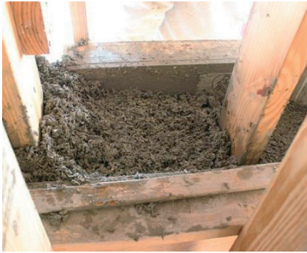
Rys. 3. Mieszanka ułożona w tymczasowym deskowaniu ściennym [6]
