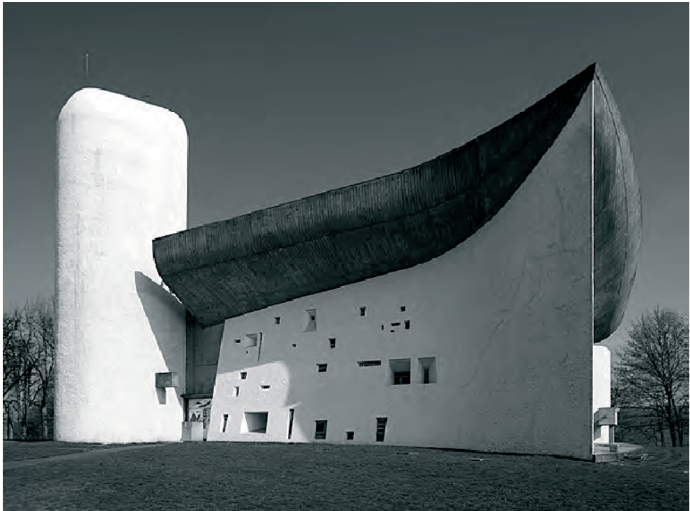
Fot. 7. Le Corbusier, kaplica w Ronchamp, elewacja wschodnia, 1950–1954. Źródło: Cezary Wąs, Antynomie współczesnej architektury sakralnej [5]
