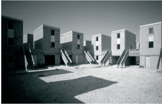
Fot. 6. Domy socjalne w wersji przed wprowadzeniem się mieszkańców. Wąskie jednostki mieszkalne pozwalają na różne możliwości rozbudowy, zarówno wewnątrz jak i na zewnątrz. Źródło: www.moma.org
