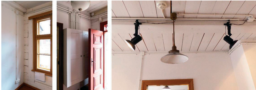
Fot. 6. Rozprowadzenie instalacji elektrycznej w budynkach
