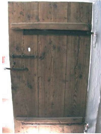
Fot. 24. Drzwi sponowe (od wewnątrz). Chałupa z Niemiec (1896 r.)
