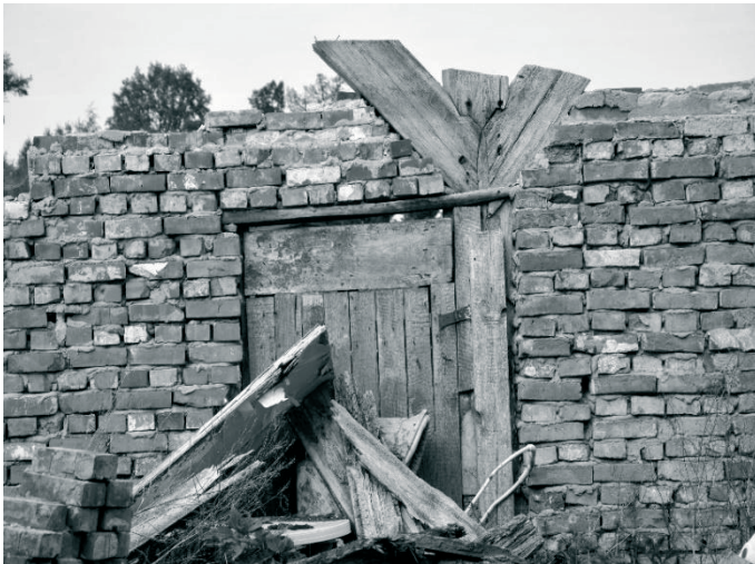
Rys. 12. Zagroda z Kaniczek, stan przed rozbiórką, słupek świadczący o pierwotnej konstrukcji szkieletowej budynku inwentarskiego, fot. M. Prarat
