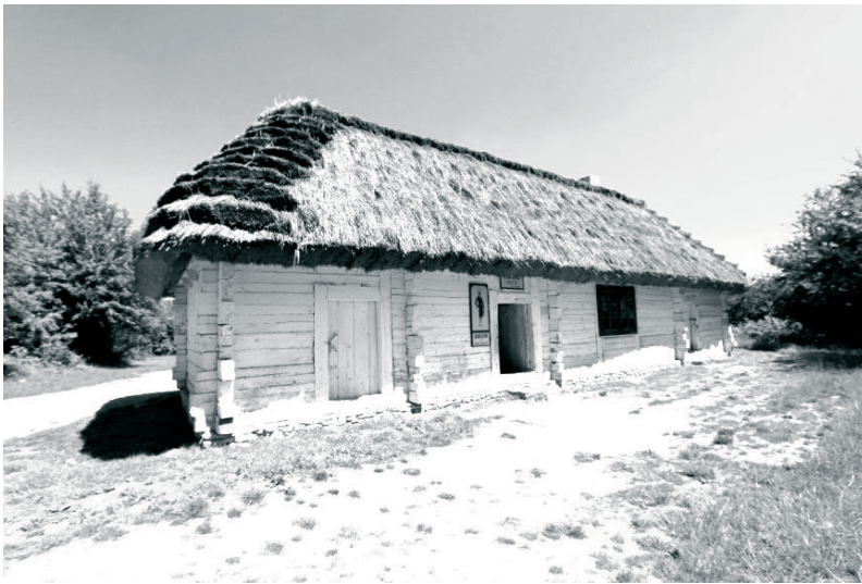
Fot. 1. Chałupa z Szydłowa – prawdopodobnie najstarszy przykład tego typu budownictwa ludowego. Dobrze widoczna jest konstrukcja na węgiel, wejście od strony szerszej ściany oraz mieszane pokrycie czterospadowego dachu. Autor: Muzeum Wsi Kieleckiej
