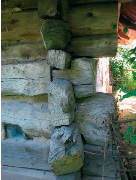
Fot. 1. Narożnik domu z drewna łupanego i ciosanego, Lublin, Muzeum Wsi Lubelskiej
