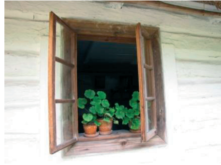
Fot. 8. Okno dwudzielne, otwierane. Chałupa z Żabna (1895 r.)
