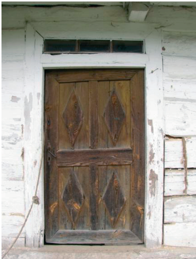
Fot. 25. Drzwi z płycinami –zdobione rombem Chałupa z Chrzążkowa (XIX/XX w.)
