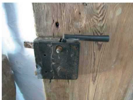
Fot. 39. Zamek żelazny kluczowy. Chałupa z Urzędowa (1784 r.)
