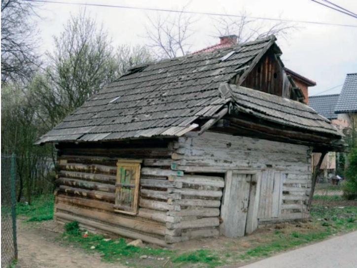
Fot. 1. Sułkowice, ul. Kowalska 72, kuźnia z 1890 r. w złym stanie, (fot. z 2015 r., autor)
