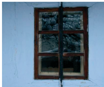
Fot. 2. Okno sześcioszybowe nieotwierane. Chałupa z Bukowej (1857 r.)
