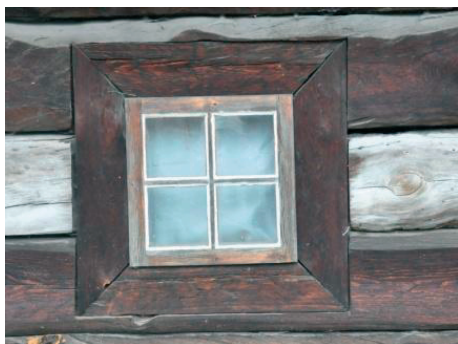
Fot. 1. Okno czteroszybowe nieotwierane. Chałupa z Brzezin (1789 r.)
