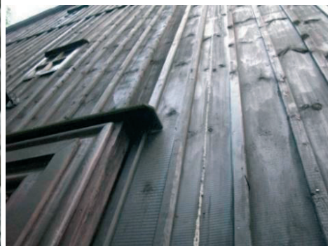
Fot. 15. Szalunek drewniany strugany maszynowo. Gąsawa, kościół z XVII w., fot. K. Wieczorek
