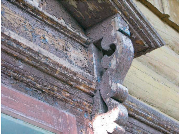
Fot. 17. Detal drewniany malowany farbą ftalową. Pałac w Julinie, 2014, fot. K. Wieczorek
