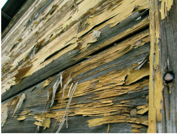
Fot. 16. Ściana drewniana malowana farbami akrylowymi. Janów Podlaski 2010, fot. K. Wieczorek
