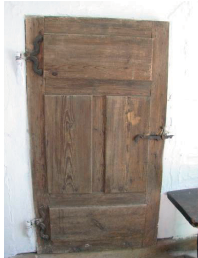
Fot. 26. Drzwi z płycinami - „filungowe”. Chałupa z Niemiec (1896 r.)
