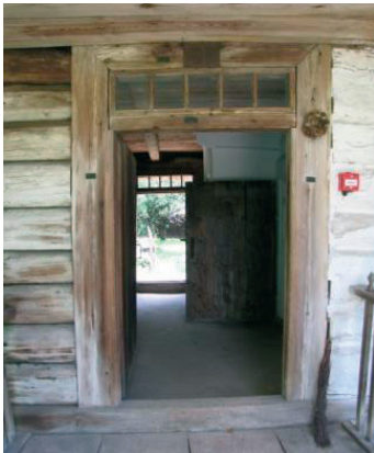
Fot. 11. Okienko nad drzwiami oświetlające sień. Chałupa z Żabna (1895 r.)
