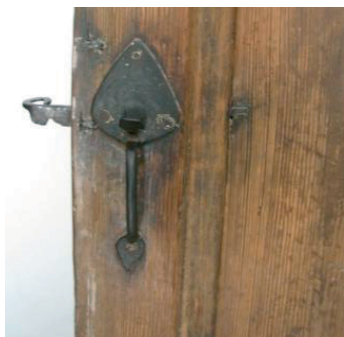
Fot. 37. Wykładka zamka zapadkowego w kształcie liścia. Chałupa z Niemiec (1896 r.)
