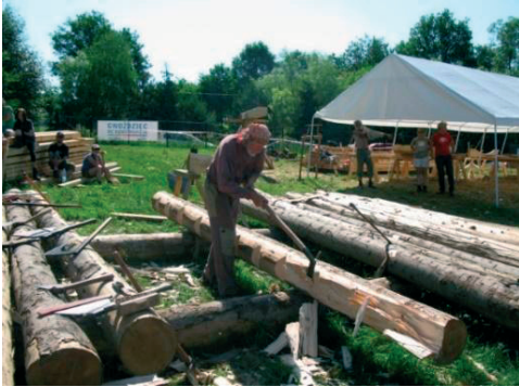
Fot. 12. Obróbka ciesielska okrągłaka. Warsztaty Gwoździec–synagoga, 2011, fot. K. Wieczorek
