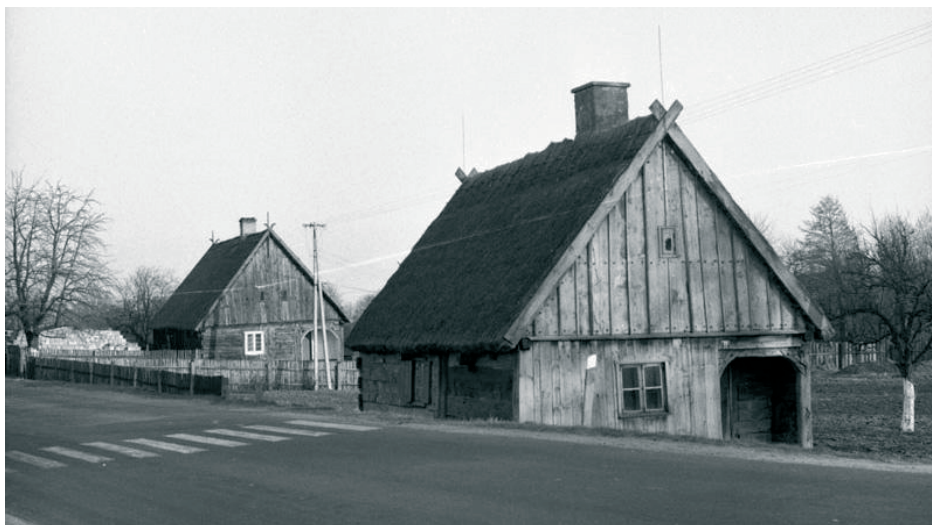
Ryc. 1. Silno (gm. i pow. Chojnice); XIX-wieczne chaty z podcieniami narożnymi przypisywane kosznajdrom; podobna forma, skala i ustawienie domów nadawały wiejskiej ulicy (Silno jest wielodrożnicą) charakterystyczny rytm; fotografia z 1974 r., autor: A. Błachowski
