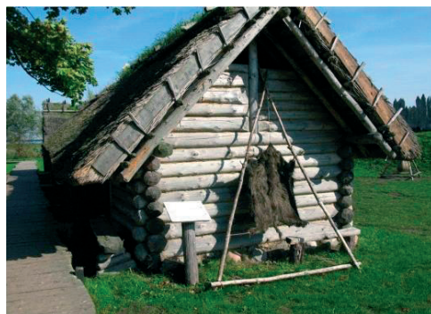
Fot. 6. Konstrukcja wieńcowa z dachem sochowym i półsochą, Wolin, skansen archeologiczny, Fot. K. Wieczorek
