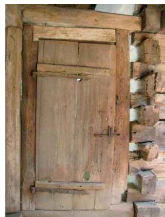
Fot. 16. Drzwi sponowe na zawiasach. Okólnik z Urzędowa (2 poł. XIX w.)
