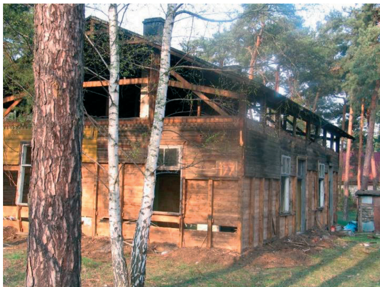
Fot. 1. Konstrukcja ścian parterowego budynku w tzw. stylu nadświdrzańskim w Warszawie – Radości (w trakcie rozbierania) – fot. A. Krajewski
