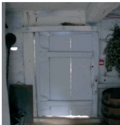
Fot. 18. Drzwi sponowe na biegunach. Chałupa z Żukowa (pocz. XIX w.)
