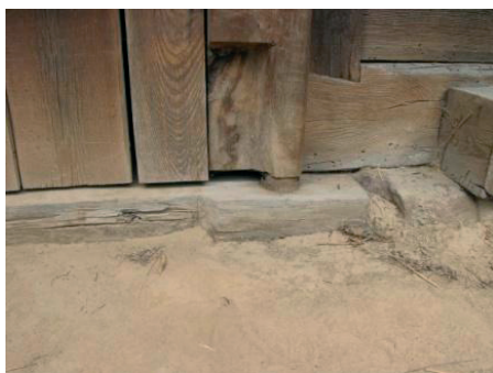
Fot. 27. Biegun dolny w stodole. Okólnik z Urzędowa (2 poł. XIX w.)
