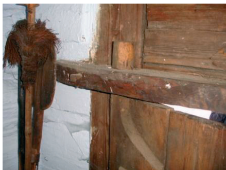
Fot. 19. Biegun górny w drzwiach sponowych. Chałupa z Bukowej (1857 r.)
