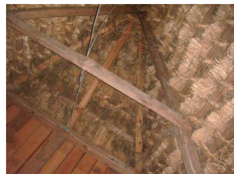
Fot. 8. Konstrukcja dachu chałupy z Rogowa
