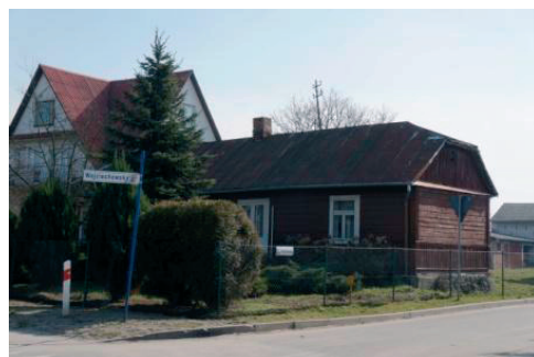
Rys. 4. Standardowe obiekty drewniane w części śródmiejskiej Uzdrowiska. Standard z modyfikacją dachu.
