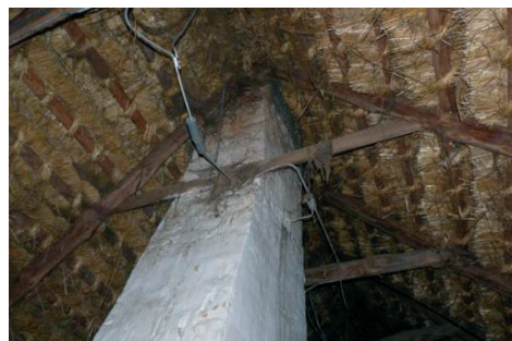
Fot. 12. Konstrukcja dachu chałupy z Niemiec
