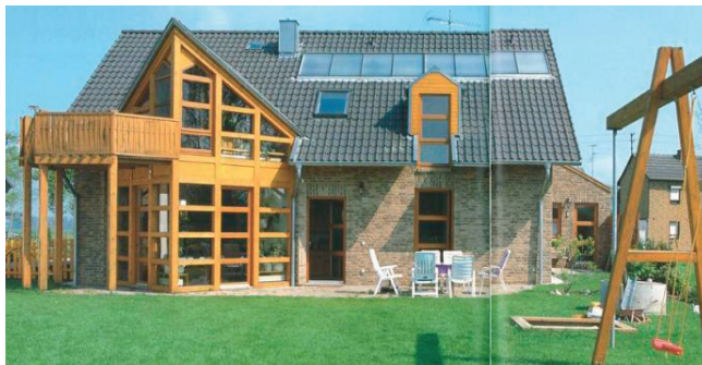
Rys. 2. Przykłady wykorzystania niekonwencjonalnych źródeł energii w domach na terenach wiejskich: a) małe elektrownie wiatrowe [19], b) duże elektrownie wiatrowe [20], c) aktywne wykorzystanie energii słonecznej [21], d) pasywne wykorzystanie energii słonecznej [22]
