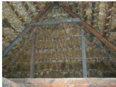
Fot. 2. Konstrukcja dachu chałupy z Błonia
