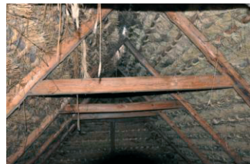
Fot. 4. Konstrukcja dachu chałupy z Brzezin
