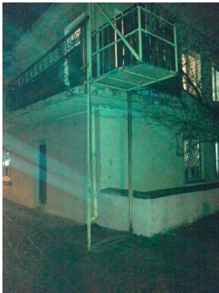
Rys. 1. Podnośnik zewnętrzny pozwalający mieszkańcowi dostać się do własnego mieszkania Luck, Ukraina (fotografia własna, 2014r.)
