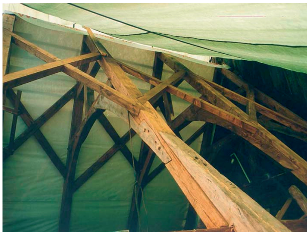
Fot. 14. Więźba dachowa prezbiterium po konserwacji w Tarnobrzegu.
