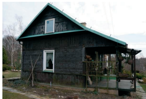
Rys. 17. Szczyt od strony północnej i zewnętrzna część użytkowa obiektu od strony zachodniej.
