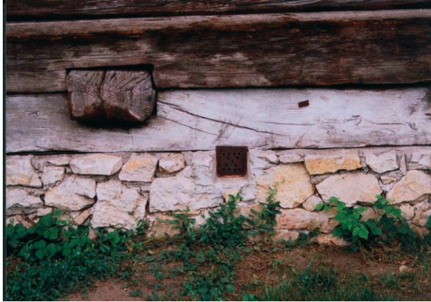
Fot. 3. Tradycyjne metody zabezpieczania podwaliny. Wysokie wyniesienie podwaliny ponad poziom gruntu zabezpiecza przed działaniem wód rozbryzgowych, śniegiem, oraz zmniejsza ryzyko podciągania kapilarnego. Podwalina wykonana z odpornej dębiny. Wentylacja podpodłogowa pod stropem przyziemia zapobiega zagrzybieniu stropu
