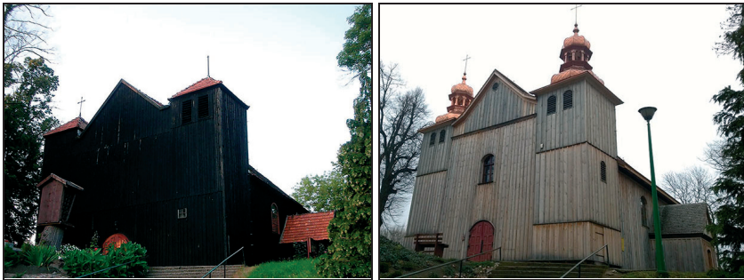
Fot. 4, 5. Kościół w Wylatowie, stan przed i po konserwacji
