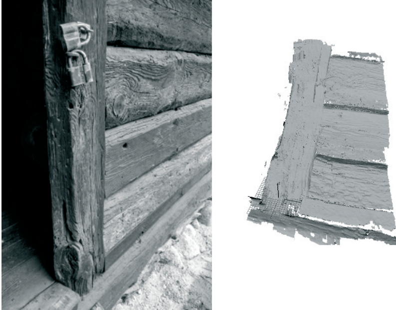
Ryc. 10. Fragment przykładowej ściany zewnętrznej budynku drewnianego z zachowaną plastiką oraz śladami obróbki (po lewej) oraz wizualizacja modelu 3D (model cieniowy) powstałego na bazie pomiarów skanerem optycznym (po prawej) – widoczna rejestracja geometrii, z zachowaniem szczegółów powierzchni mierzonej. Muzeum Wsi Radomskiej. [ Fot. i oprac. R. Zapłata]
