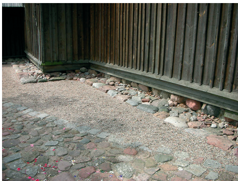
Fot. 8. Zachowany płaszczyz kamienny w Tarnowie Pałuckim
