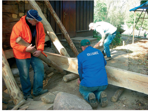
Fot. 11. Montaż podwalin w Wylatowie
