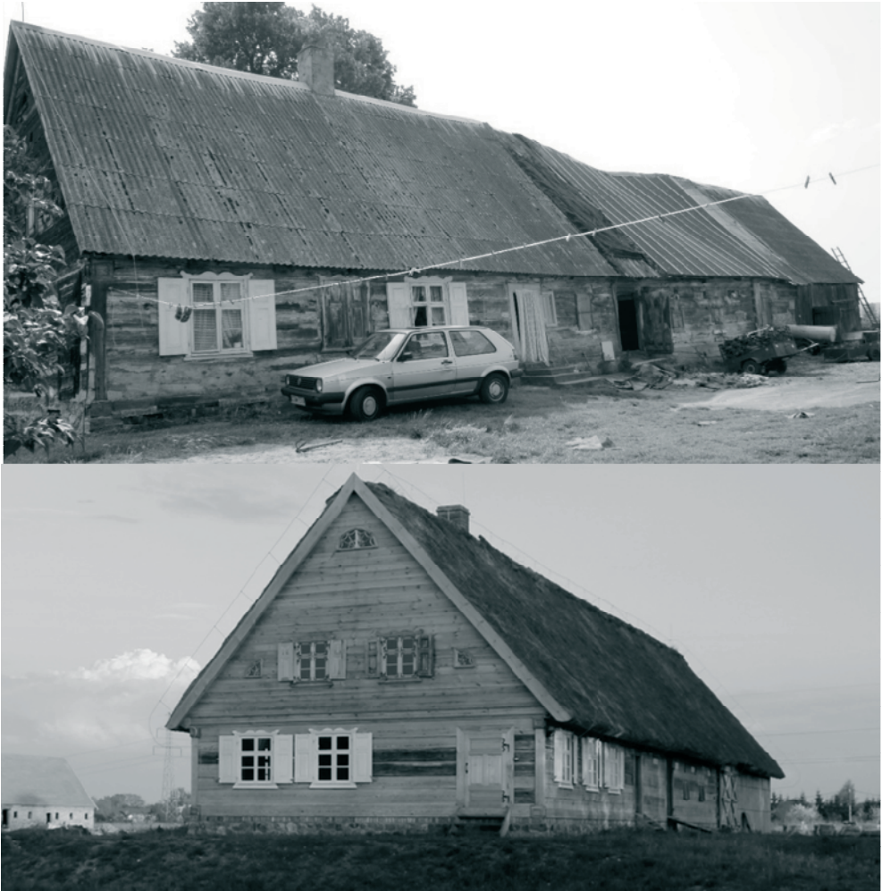
Il. 4. Zagroda z Niedźwiedzia przed i po przeniesieniu na teren Olęderskiego Parku Etnograficznego w Wielkiej Nieszawce (fot. M. Prarat 2009 i 2015).
