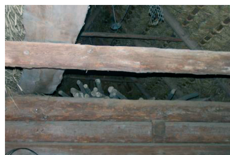
Fot. 10. Konstrukcja dachu Okólnika z Żabna
