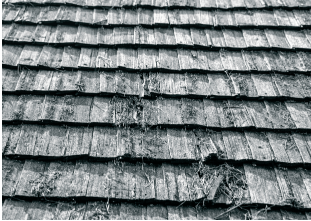
Ryc. 3. Przykład pokrycia dachowego (olejarnia z poł XX w.) – dach dwupołaciowy pokryty gontem. Przykład powierzchni ‘trudnej’ w dokumentacji tradycyjnej - zróżnicowana forma, zanieczyszczona, o niejednorodnej fakturze. Muzeum Wsi Radomskiej. [Fot. R. Zapłata]
