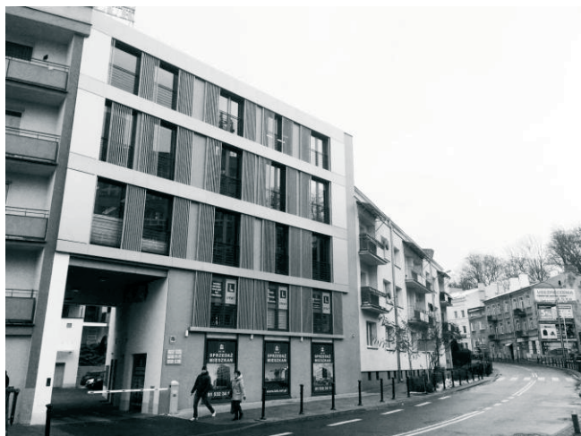
Rys. 5. Budynek mieszkalny przy ul. Stanisława Leszczyńskiego 15 w Lublinie (fot. Autor)
