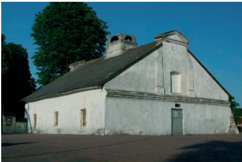
Rys. 16. Szpitalik – elewacje północna i wschodnia – obecnie. Źródło: Oprac. własne
