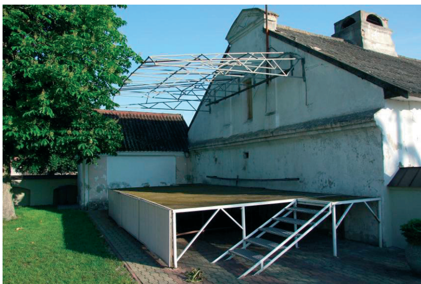
Rys. 17. Szpitalik – elewacja południowa i fragment kostnicy oraz scena – obecnie. Źródło: Oprac. własne
