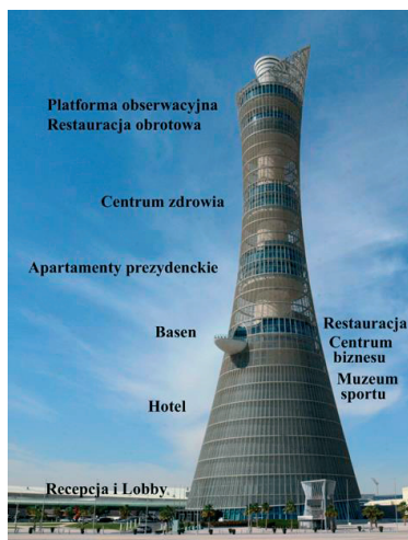
Rys. 17. Aspire Tower (300 m, 2007, projekt Hadi Simaan wraz z zespołem projektowym Arup), fot. wykonana przez autorów
