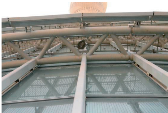
Rys. 22. Aspire Tower - konstrukcja stalowej fasady, fot. wykonana przez autorów
