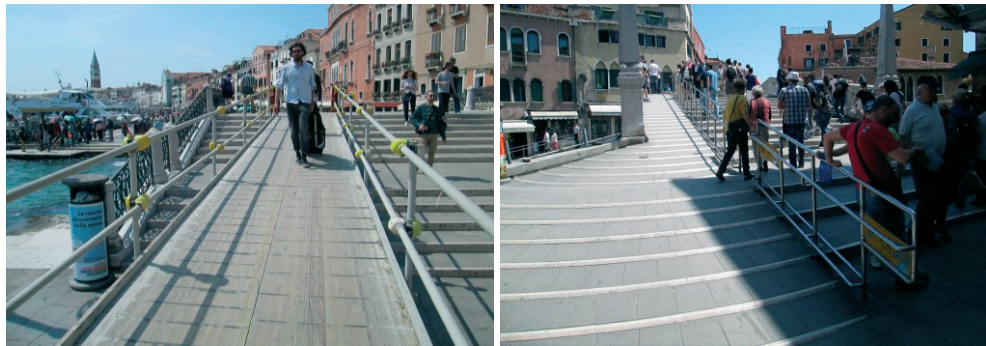
Fot. 29,30. Wenecja. Dostosowanie mostów pieszych do transportu na wózkach. Z lewej: rozwiązanie prowizoryczne, ale funkcjonujące od kilku lat i sprawdzające się pod względem użytkowym – most nad Rio Ca' di Dio na końcu Riva degli Schiavoni. Z prawej: most dostosowany do ruchu wózków w sposób trwały i nawiązujący do jego zabytkowej formy – Ponte delle Guglie nad Canale di Canareggio. Zdjęcia Hubert Trammer (25 i 28 maja 2016 roku)
