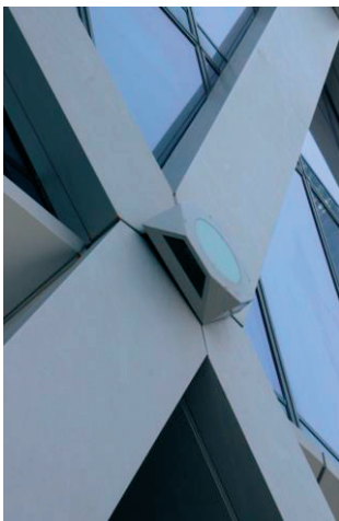
Rys. 14. Tornado Tower – element diagonalnej siatki w formie stalowej kratownicy pokrytej aluminiową nakładką ze śrubą, fot. wykonana przez autorów
