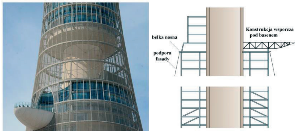
Rys. 21. Aspire Tower – konstrukcja wsporcza basenu, fot. i opracowanie konstrukcji wykonane przez autorów
