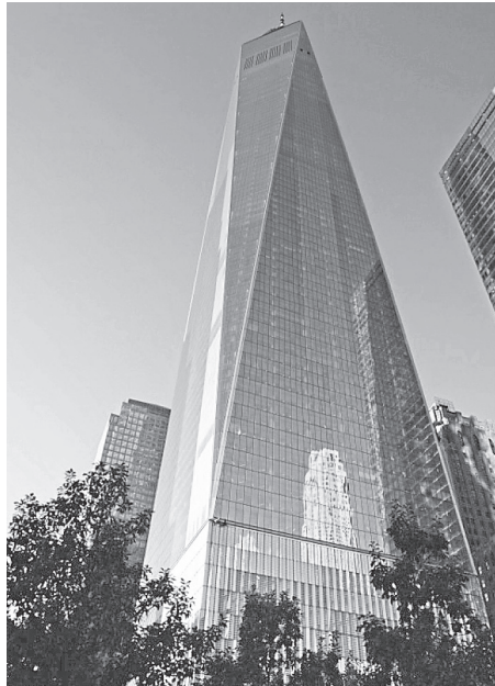
Rys. 5. Fasada budynku 1WTC, fot. wykonana przez autorów
