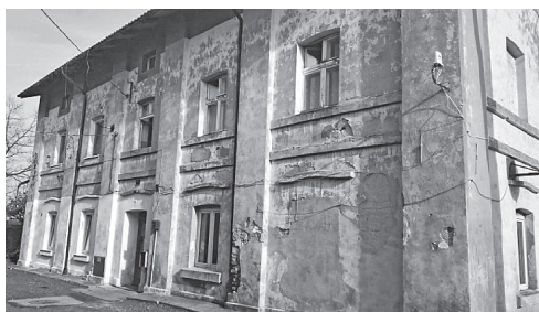
Rys. 8. ul. Zaulek Fabryczny 1, front budynku
