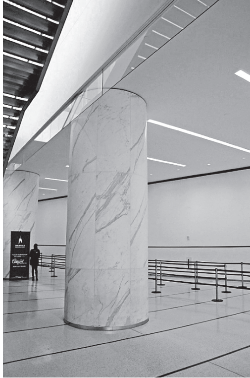
Rys. 10. Żelbetowy słup nośny w zewnętrznej części budynku na poziomie pierwszej kondygnacji poniżej lobby, fot. wykonana przez autorów
