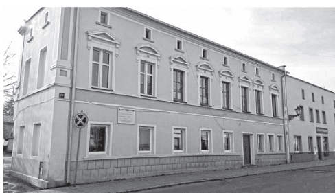
Rys. 6. ul. Kolejowa 20, front budynku
