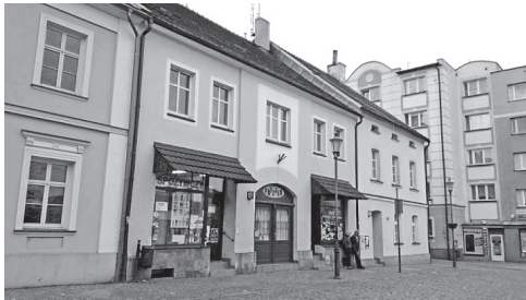
Rys. 13. ul. Rynek 6, front budynku
