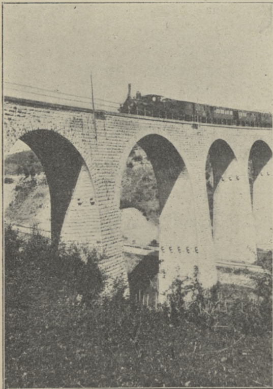
WIADUKT KOLEJOWY NA LUBIEŻNEJ
