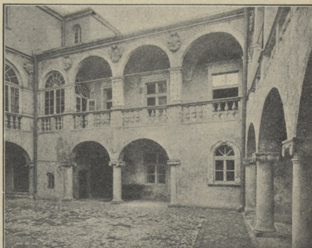
DZIEDZINIEC DOMU PRZY UL. KANONICZNEJ L. 21. W KRAKOWIE
