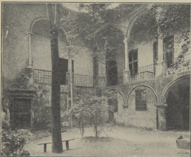
DZIEDZINIEC DOMU PRZY UL. KANONICZNEJ L. 18 W KRAKOWIE.
