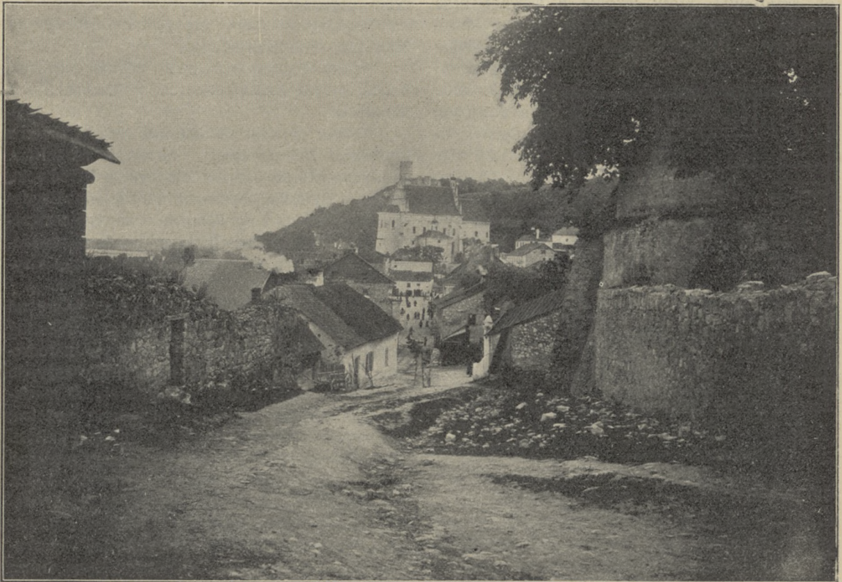
WIDOK OD KLASZTORU REFORMATÓW NA GÓRĘ ZAMKOWĄ W KAZIMIERZU.
