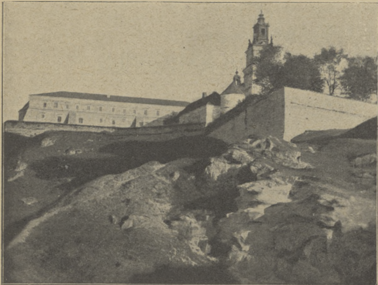
KLASZTOR W PODKAMIENIU (OD ZACHODU), POW. BRODZKI.
