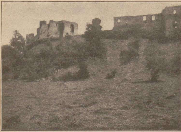
Ryc. 130. OGÓLNY WIDOK RUIN ZAMKU W PNIOWIE Fot. W. Fischer.
