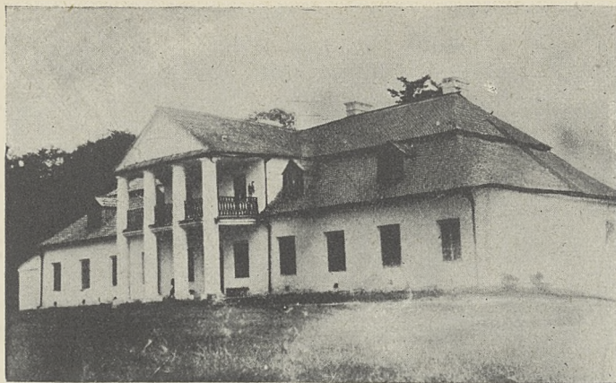
Ryc. 133. DWÓR W KRZEMIĘNCU O DACHU „POLSKIM” Z GANKIEM PIĘTROWYM.
