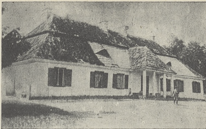
Ryc. 140. DWÓR O GANKU CZTEROSŁUPOWYM W WĘGRZYNOWICACH I O DACHU POLSKIM „PIĘTRZYSTYM” O JEDNEJ POCHYLEŃSI, Z GZEMSEM W POŁOWIE WYSOKOŚCI.
