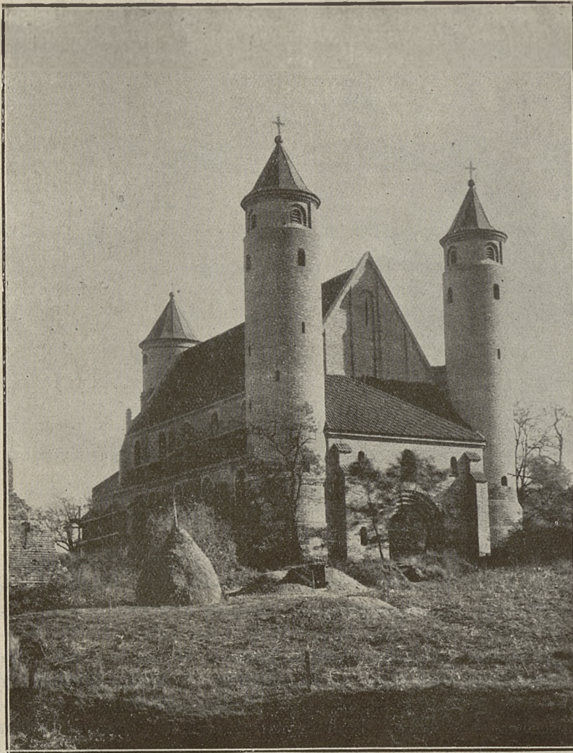
Ryc. 82. Kościół w Brochowie, powiat sochaczewski, od zachodu. (od strony rzeki Bzury).
