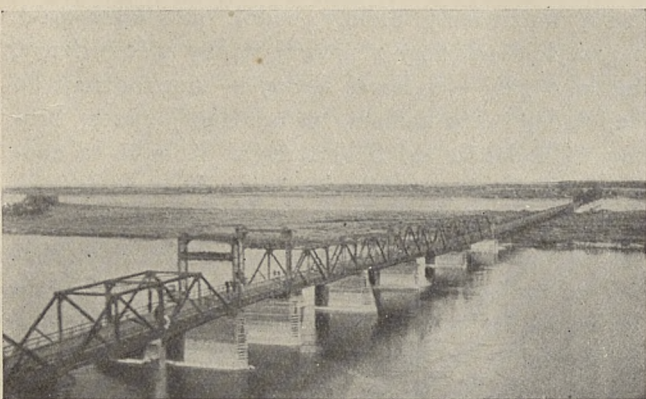
Ryc. 207. Most na Wiśle pod Wyszogrodem. Fot. W. Nowakowski.
