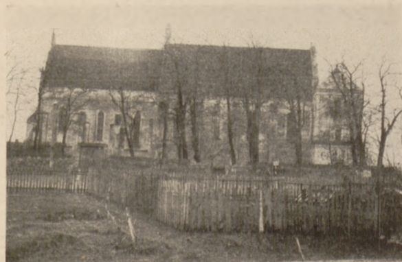
Ryc. 77 Kościół pofranciszkański w Nowym Korczyńnię od strony północnej
