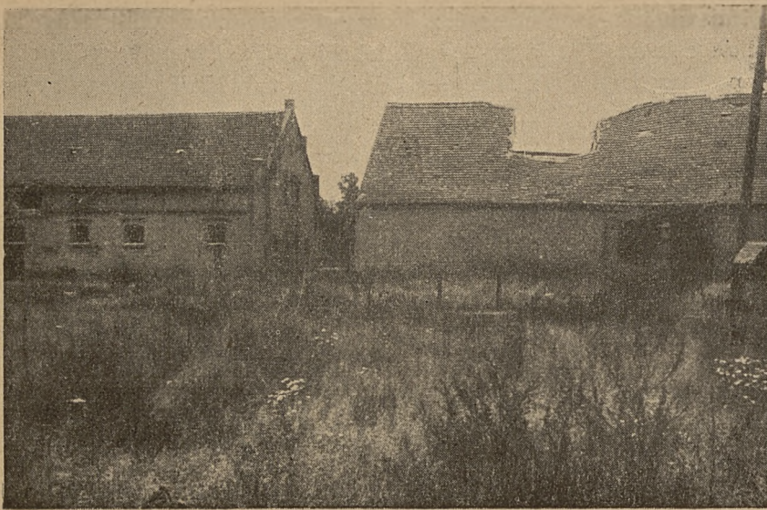
W wyniku działań wojennych tutejsze wsie i majątki zostały w większości b. silnie zniszczone. Odbudowa czyni jednakże szybkie postępy. (Przed odbudową)
