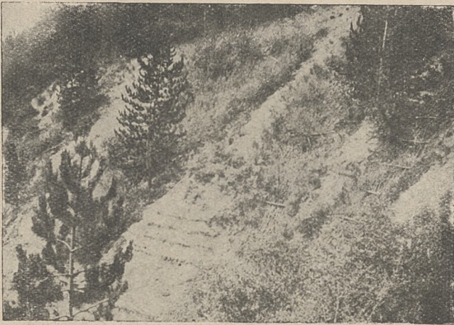
Ryc. 25. Fragment stoku w okresie wykańczania prac nad ustaleniem gleby na zboczu i nad wprowadzeniem pokrywy roślinnej.
