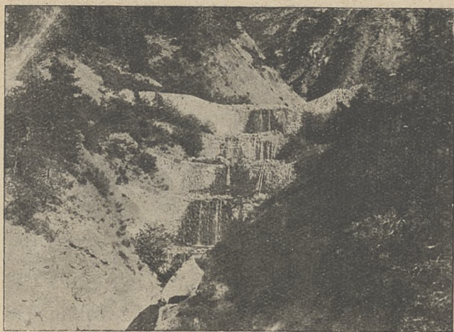
Ryc. 21. Grupa zapór systemu Breton (Nr. 4) w wąwozie Riou-Chanal.
