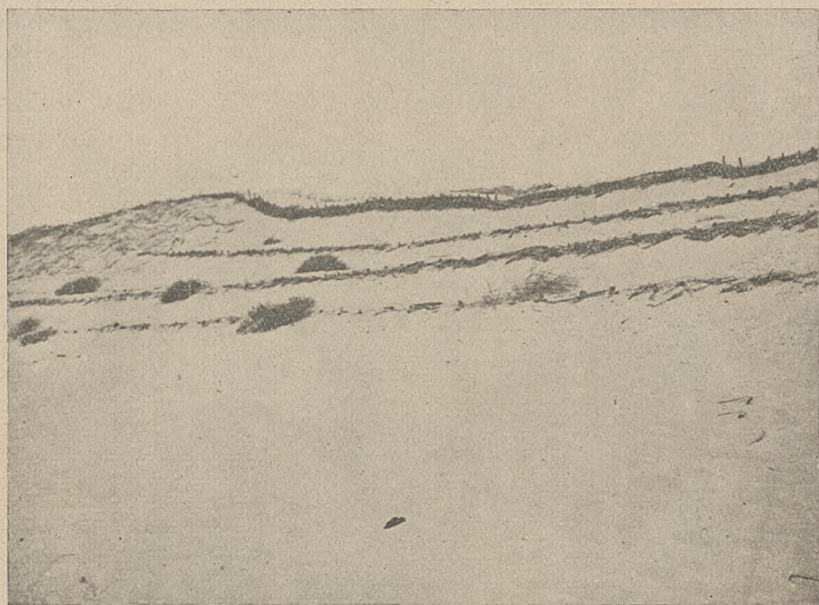
Ryc. 5. Wzmacnianie dżuny nadbrzeżnej zapomocą opłotków.
