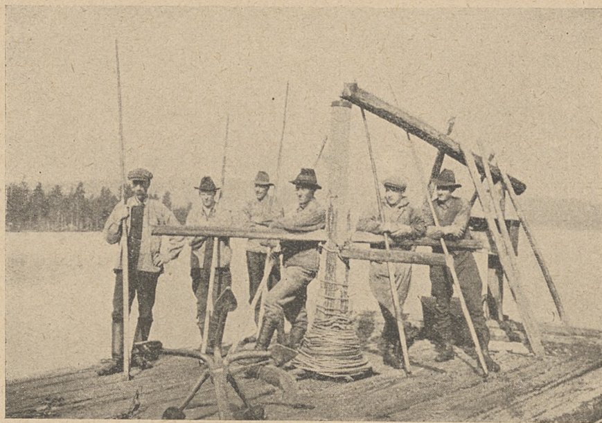
Ryc 4. Tratwa z kołowrotem do holowania kloców na jeziorze.
