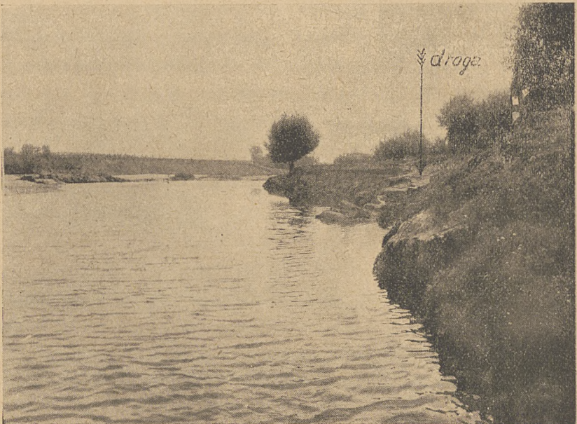
Rys. 2. Potok Wyrwa w Paćkowicach. Zerwana droga.
