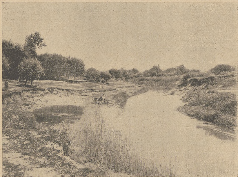
Rys. 4. Rzeczka Wiar. Zdziczałe koryto przez zniszczenie tamy obustronnie obudowanego koryta rzeki.
