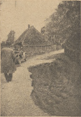
Rys. 1. Potok Struga-Drabinianka pod Rzeszowem. Szkarpa drogi oberwana wraz ze starymi drzewami.
