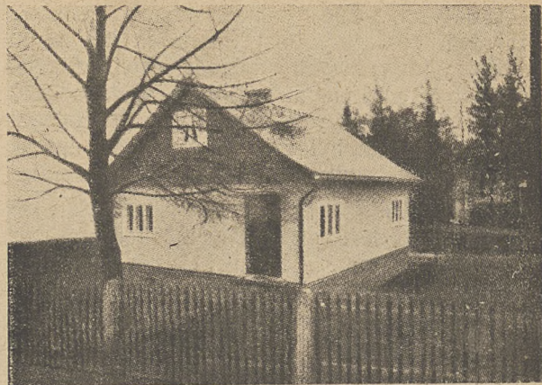
Fot. 2 — dom wyłożony również płytami pilśniowymi, miękkimi — otynkowany.
