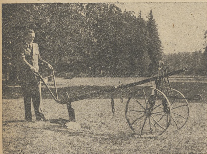
Racjonalizator J. Nowicki z plugiem swego pomysłu do wyorywania większych sadzonek
