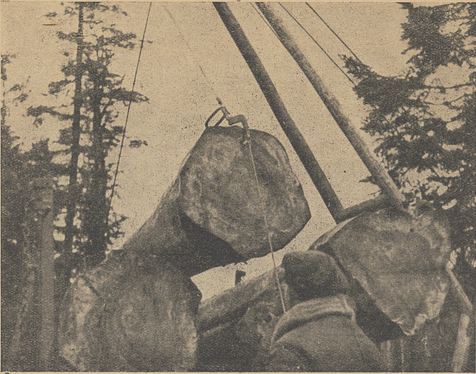
Fot. 2 — Na zdjęciu widzimy hak, będący ważną częścią urządzenia żurawia, o którym mowa w artykule.
