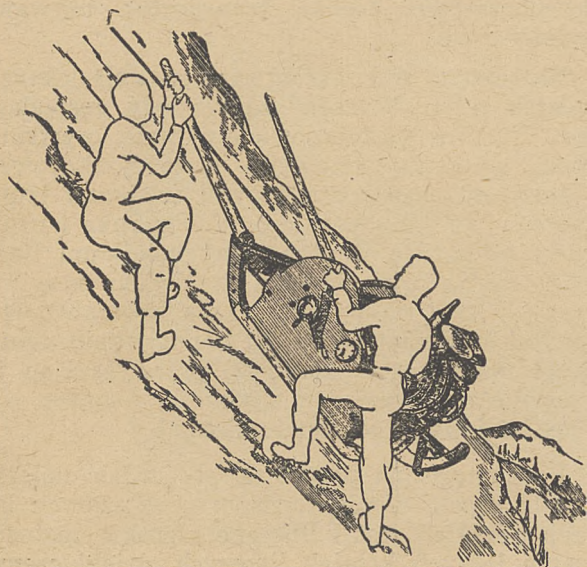
Rys. 3 — Wciągarka motorowa zmontowana na sankach
