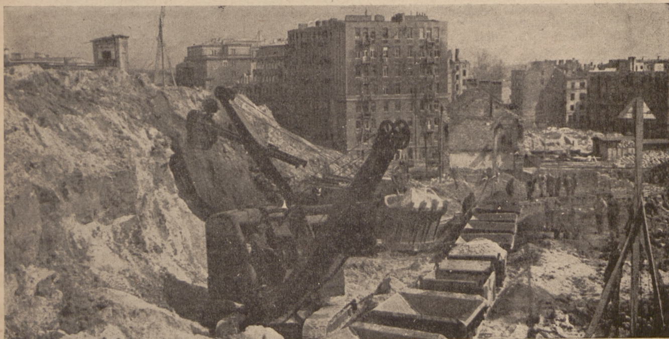
Kopaczka mechaniczna przy pracy na trasie W-Z.
