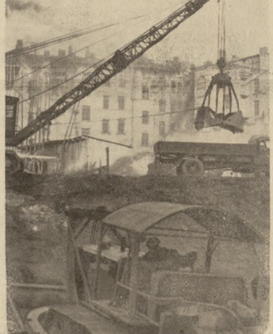
Prace mechaniczne coraz wydatniej pomagają nam przy budowie nowych osiedli mieszkaniowych i ośrodków fabrycznych. Przyniesiają wykonanie robót i zaspędy wyśk ludzkich męści. Na zdjęciu: spychacz, dźwigi i samochody przy budowie Marszałkowskiej Dzielni Mieszkanowej w Warszawie.
