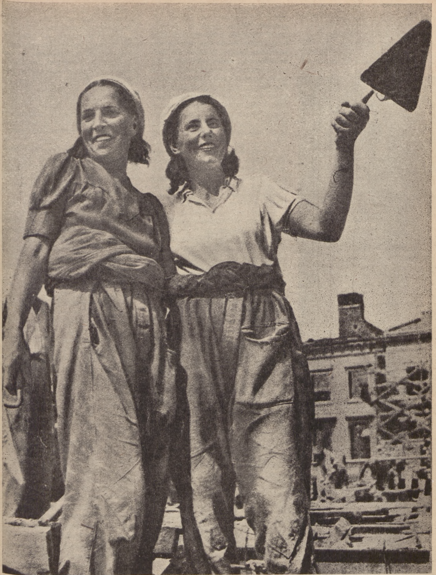
„Budując nasz kraj, budujemy pokój“ — mówią murarki warszawskie: G. Michalkowa i S. Kropielnicka
