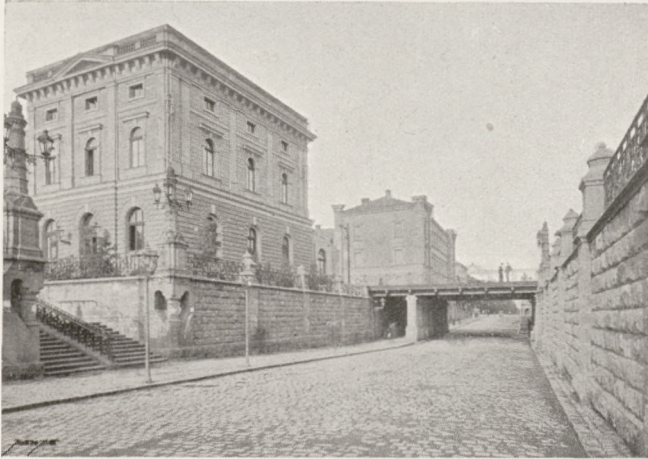
Podkop kolejowy przy ul. Lubicz.
