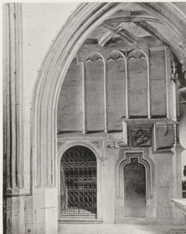
Fig. 87. Widok na spód wieży zegarowej w nawie północnej.
