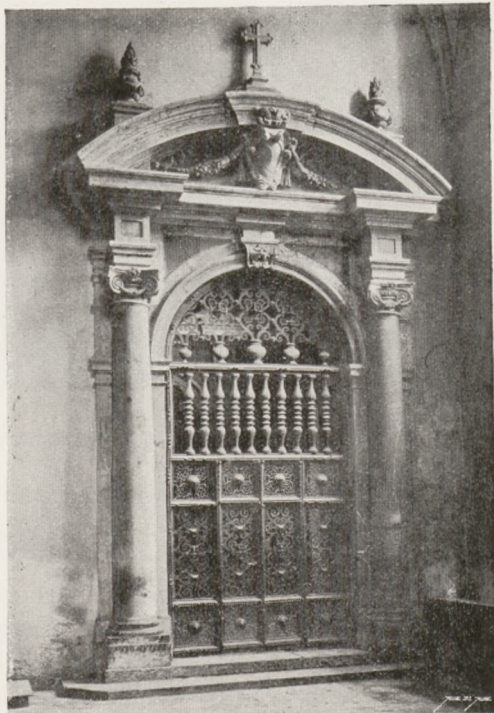
Fig. 140. Portal kaplicy ks. Lubomirskich u Dominikanów.
