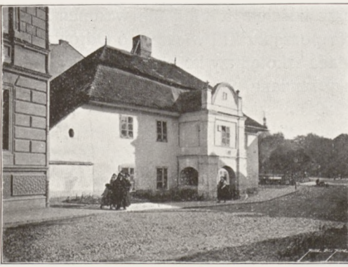
Fig. 19. Dworek przy ulicy Basztowej.
