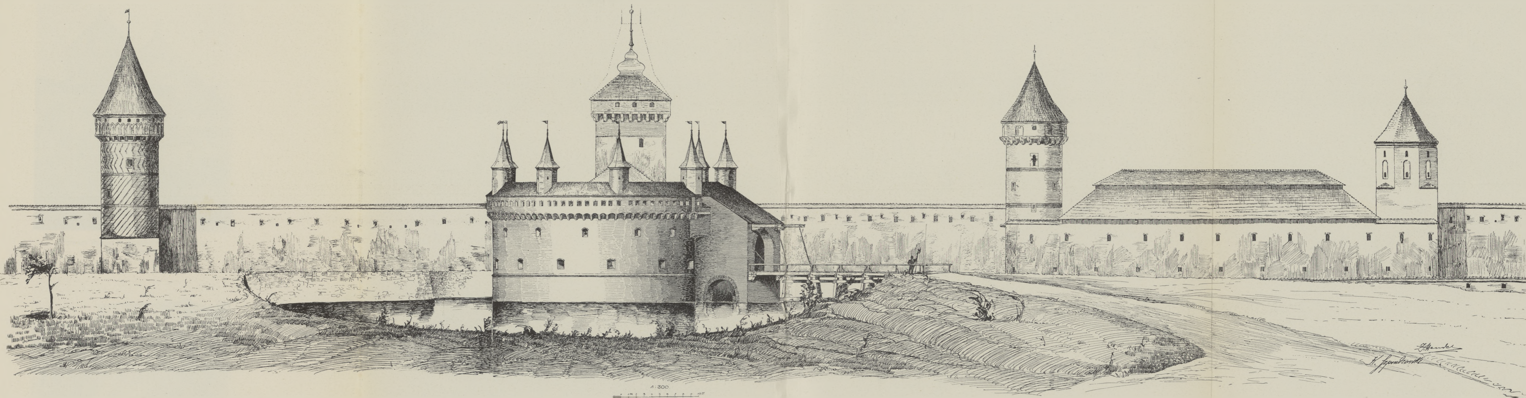
WIDOK PANORAMICZNY NA BARBAKAN, BASZTY I MUR MIEJSKI.
