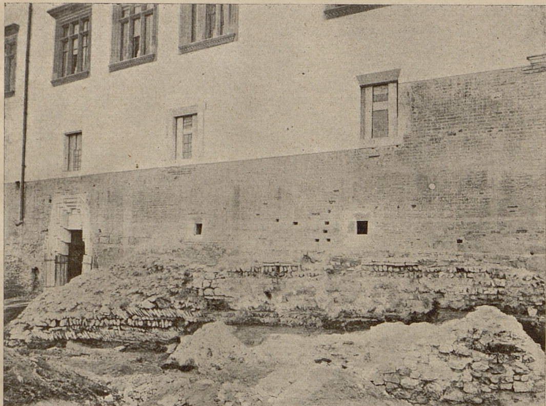
Fig. 6. Mur fundamentowy sali o 24 słupach.
